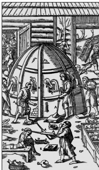
Slika 2. Staklarska radionica, prema G. Agricola, 16. stoljeće (N. TOPIC, 2019., 17)
