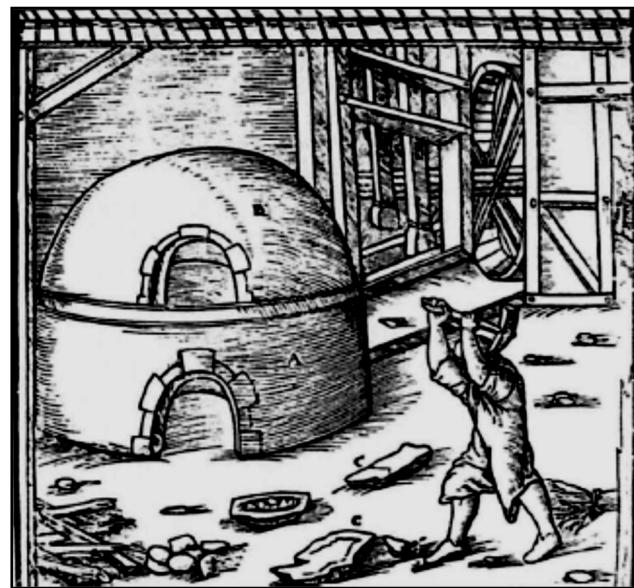
Slika 1. Primjer kružne peći, prema G. Agricola, 16. stoljeće (D. STIAFFINI, 1999., Fig. 10)
