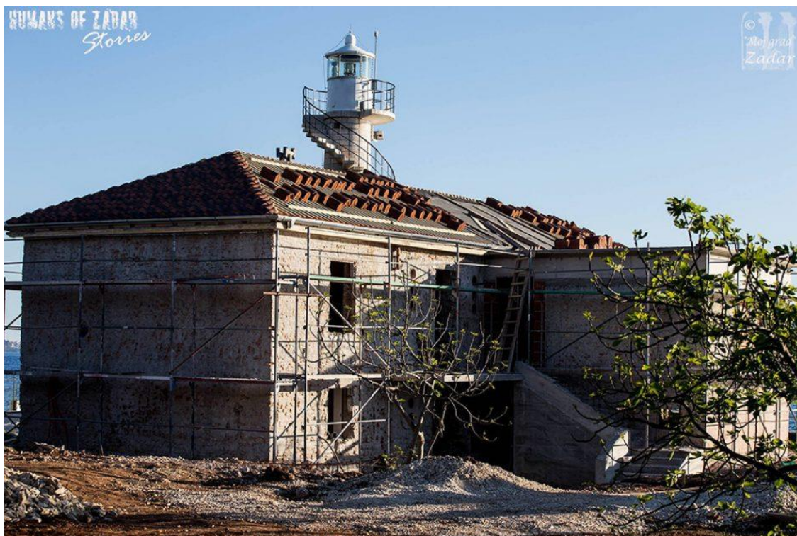
Slika 5. Obnova devastirane zgrade svjetionika
