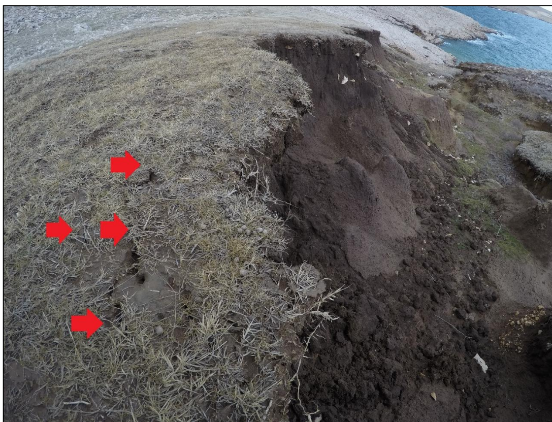
Slika 170. Nastanak tenzijskih pukotina prije odronjavanja naslaga tla
