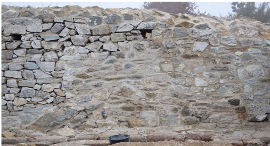
Sl. 27. Građevinska tehnika zidova (foto: L. Gashi, 2018.).
