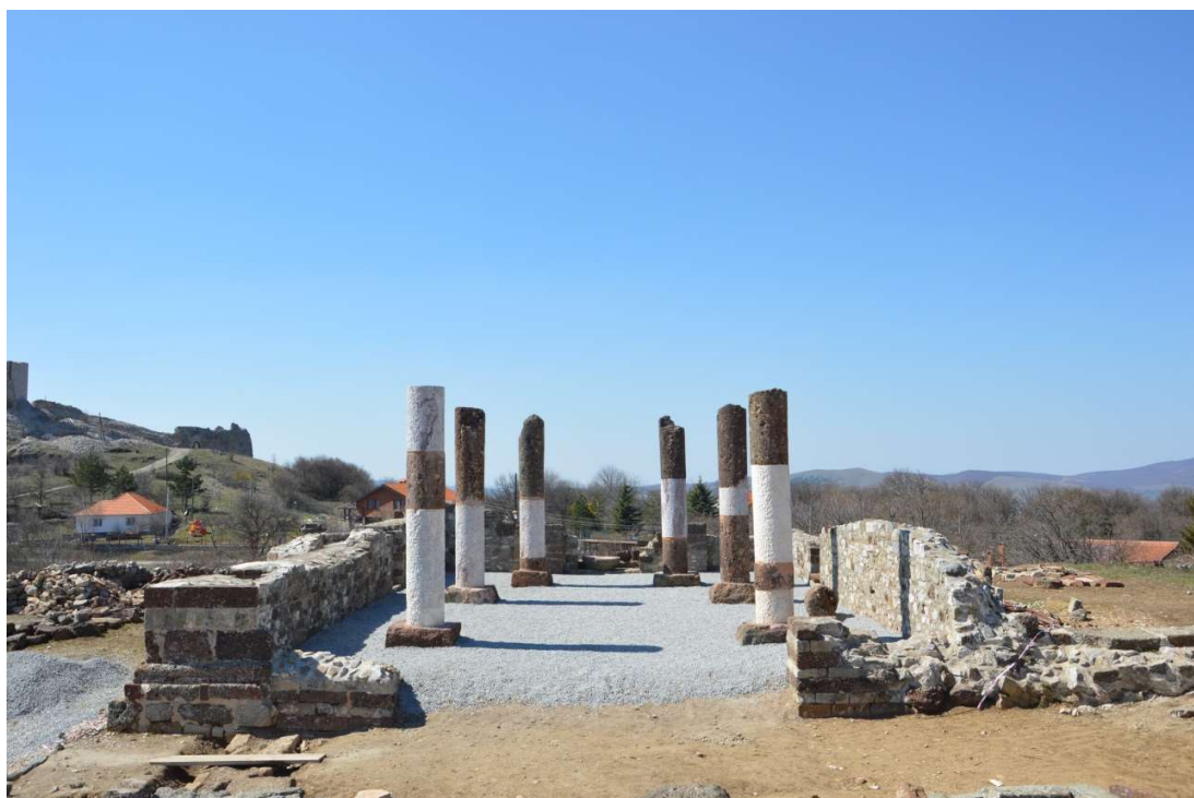
Sl. 35. „Katedrala“ nakon konzervatorsko-restauratorske intervencije (foto: L. Gashi, 2018.).
