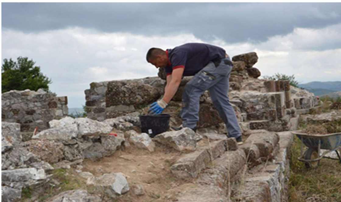
Sl. 26. Faza konsolidacije zidova (foto: L. Gashi, 2018.).
