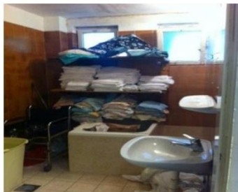
Slika 3: PB Lopača, Odjel integralne psihijatrije (ženski dio), kupaonica koja nije u uporabi već se koristi kao skladište.
