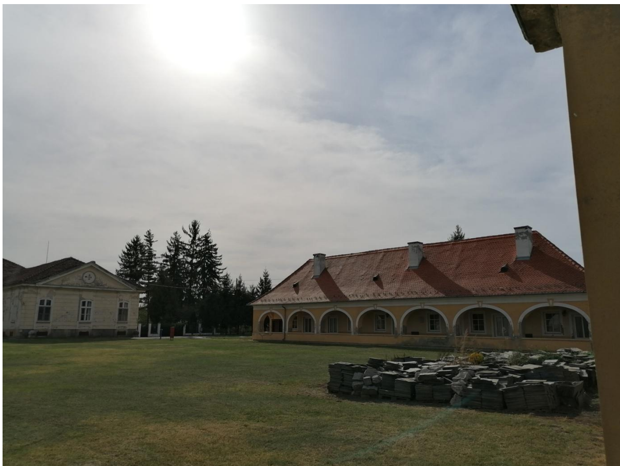
Prilog 7. Gospodarska zgrada na zapadnoj strani ulaznog dvorišta, izvor: osobna fotografija
