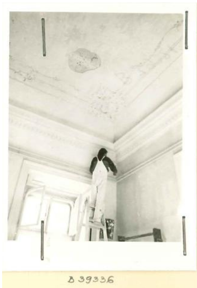
Slika 21. Svečana dvorana, završni vijenac sa zuborezom (dentima), izvor: MK-UZKB-KOS-B 39336
