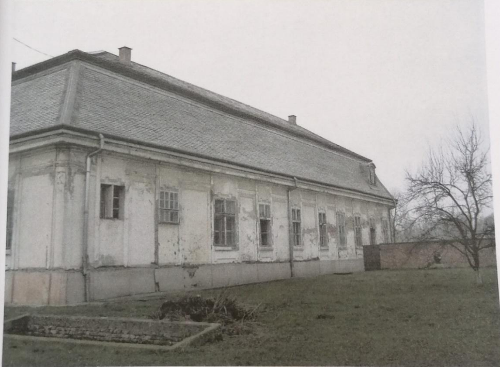
Južno i istočno pročelje istočnog krila
