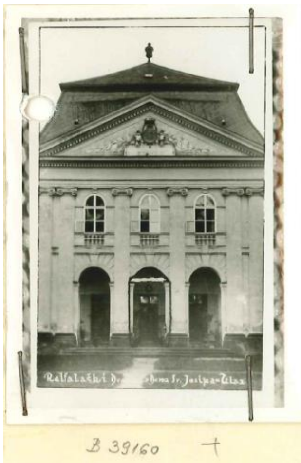
Slika 15. Sjeverno pročelje dvorca, izvor: MK-UZKB-KOS-B 39160
