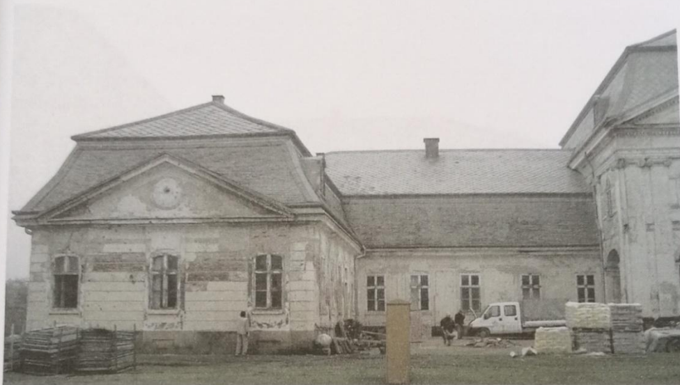
Sjeverno pročelje istočnog krila
