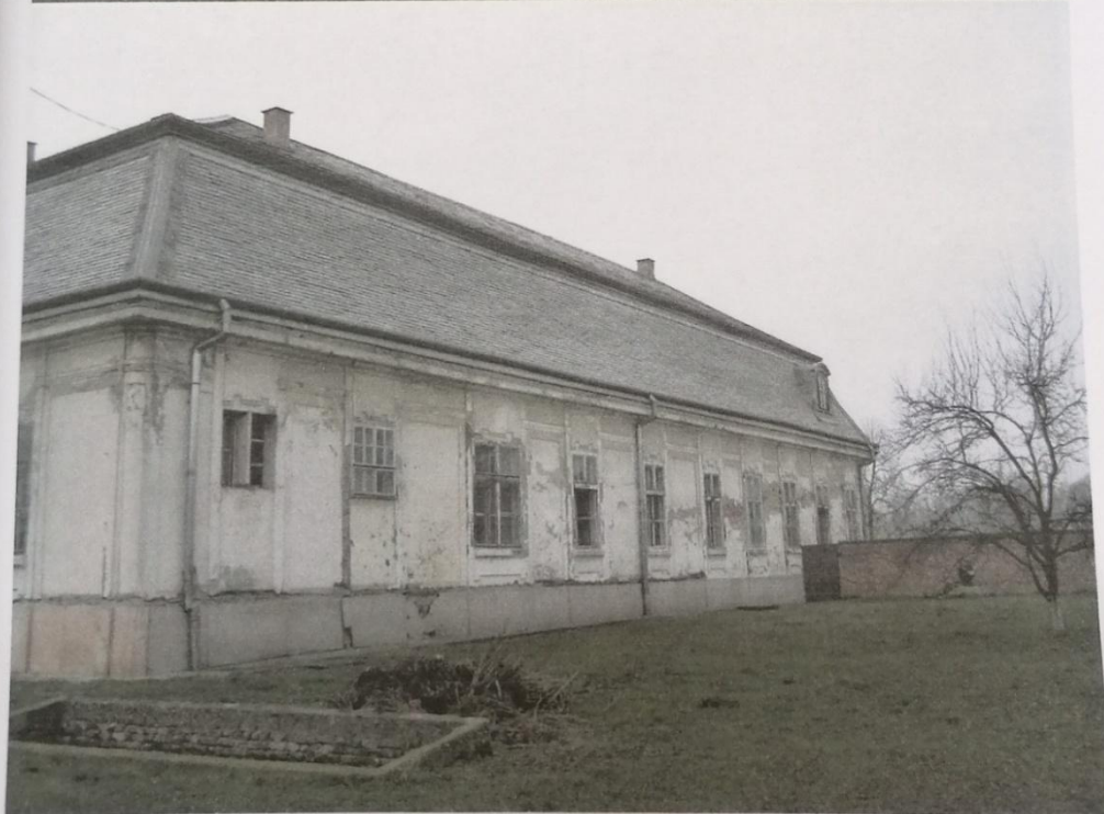
Južno i istočno pročelje istočnog krila
