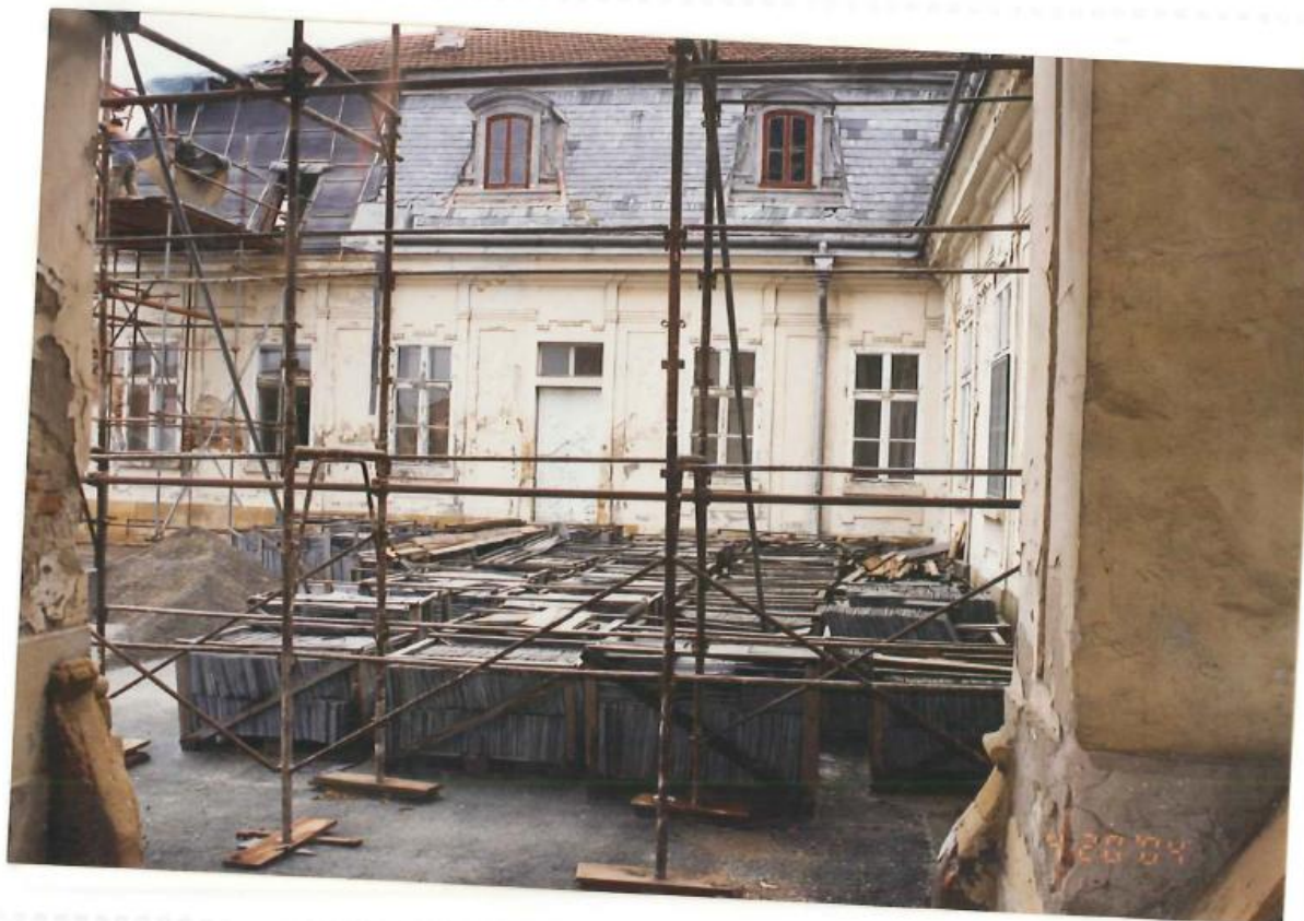
Slika 27. Radovi na rekonstrukciji krovšta nad istočnim krilom, izvor: MK-UZKB-KOS
