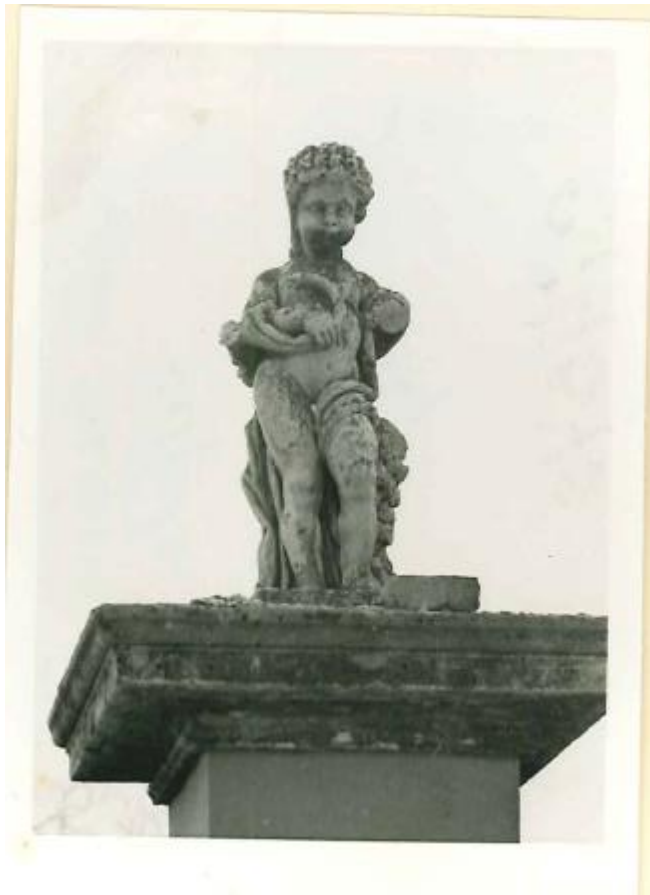
Slika 25. a Oštećenja na skulpturama ograde dvorca, izvor: MK-UZKB-KOS-B 14362
