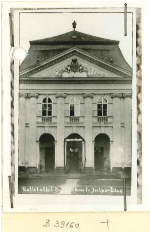
Slika 15. Sjeverno pročelje dvorca, izvor: MK-UZKB-KOS-B 39160
