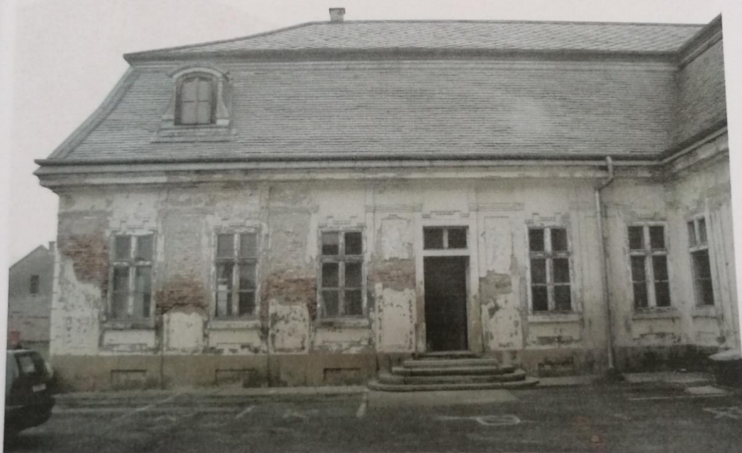
Zapadno pročelje istočnog krila
