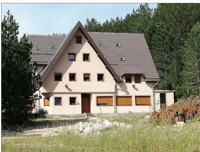
Slika 53. Novoizgrađeni objekt, Masna Luka
