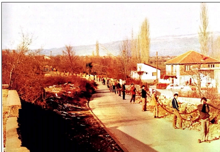
Slika 16. Postavljanje telefonskog kabela 1960-ih godina kroz Jare (Široki Brijeg)
