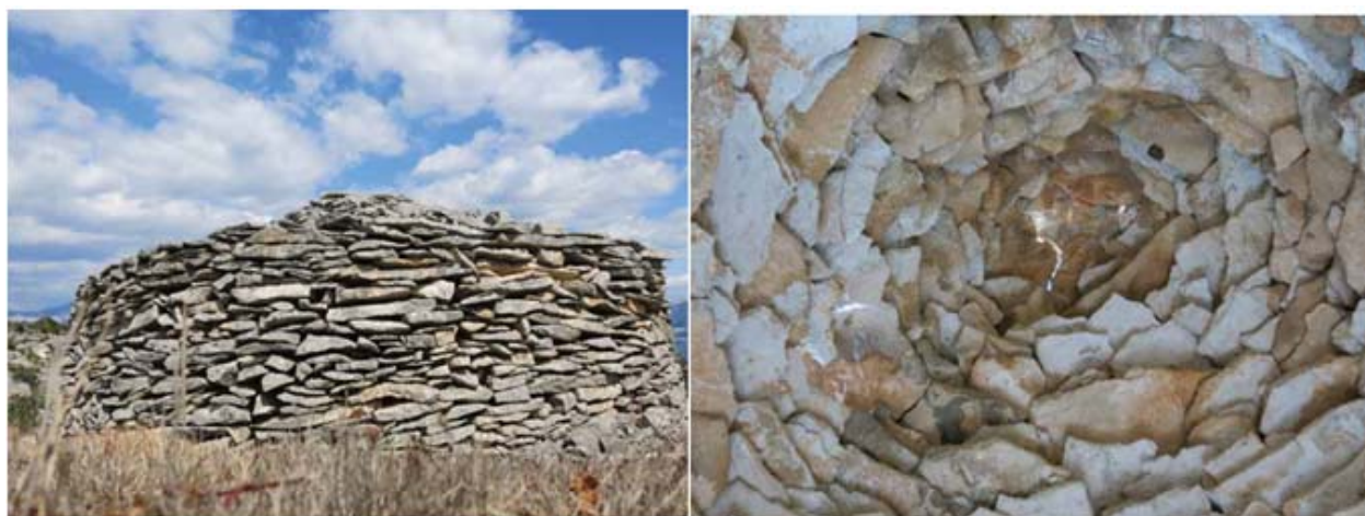
Slika 74. – Prikaz bunje i njezine unutrašnjosti (preuzeto od: http://www.dragodid.org/materijali/Bracki_suhozidi_small.pdf )
