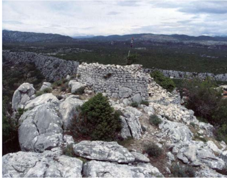
Slika 13. Ostatci kule Avale (I. ALDUK, M. TOMASOVIĆ, 2008, 169).
