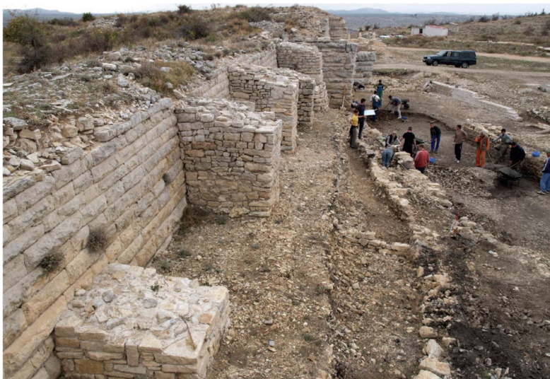
Slika 25. Pogled na sjeverni kasnorepublikanski bedem Asserije s kasnoantičkim kontraforima (Ž. TOMIČIĆ, 2010, 374)
