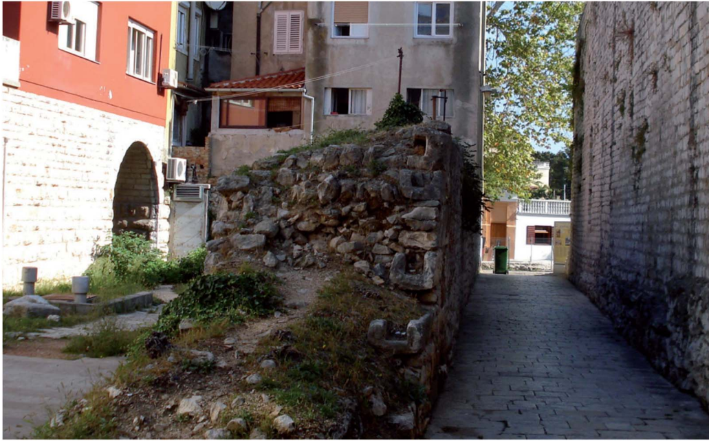
Slika 14. Ostatci kasnoantičkih zidina s upotrebom kamenih žlijebova s akvedukte (V. JOVIĆ, GAZIĆ, 2011, 186)
