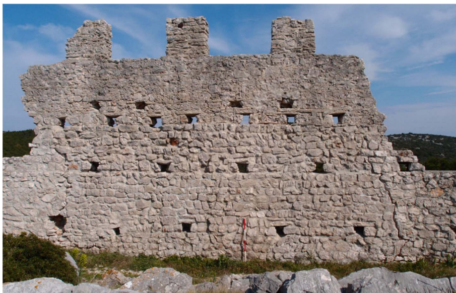
Slika 3. Segment unutrašnjeg bedema na Gradini s očuvanim kruništem te vidljivim četvrtastim rupama za usađivanje drvenih greda (E. PODRUG et al., 2016, 64)
