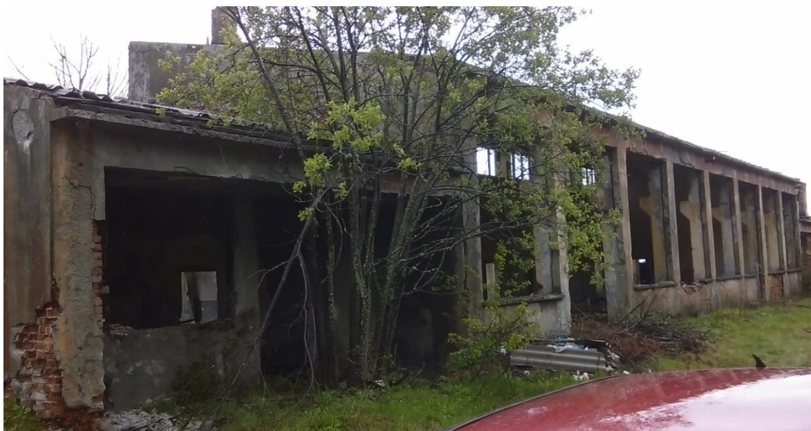
Slika 1. Primjer malog dijela postrojenja nekadašnje željezare (izvor: Adriana Pojatina)
