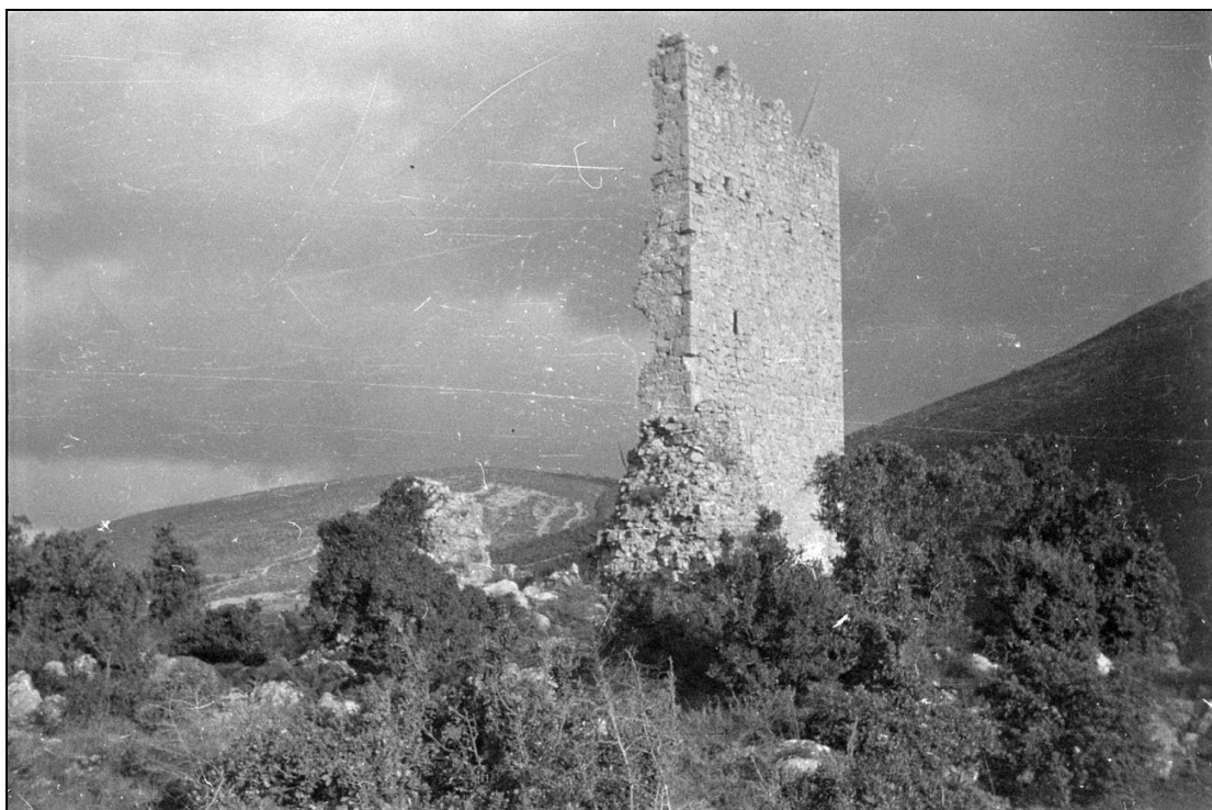
Sl. 7. Ostaci srednjovjekovne kule Turan – Gradac, 1952. (Pismohrana AMI-ja)
