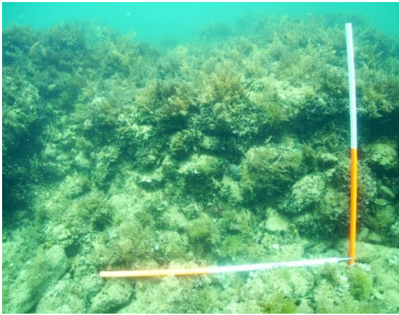
Sl. 32. Uvala Kocište. Kamenomet na čelu lukobrana.
