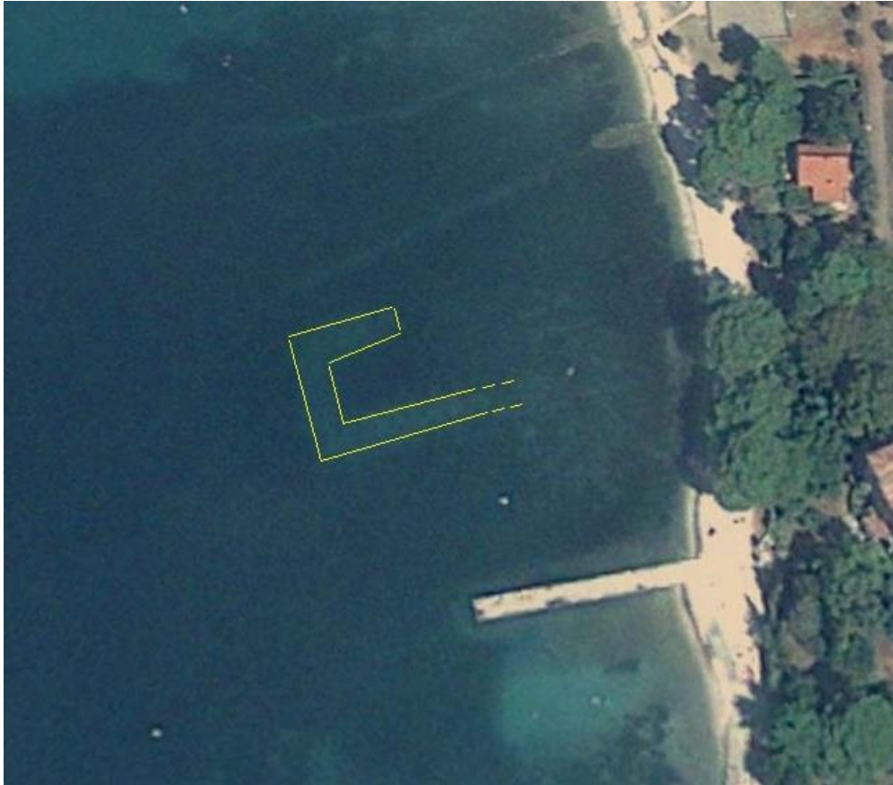
Sl. 27. Izlomljeni lukobran na rtu Mede.
