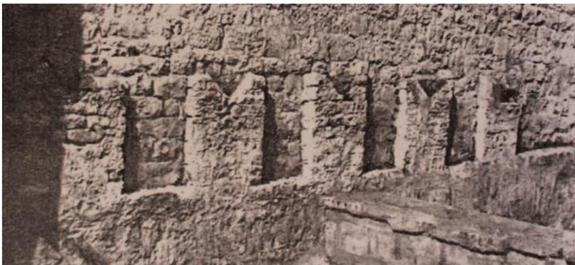
Prilog 12. Primjer ograđenog dvorišta, Severova ulica
