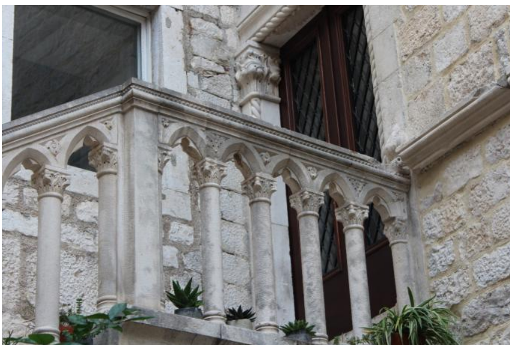
Prilog 43. Detalj kamenog stubišta u palači kraj Zlatnih vrata
