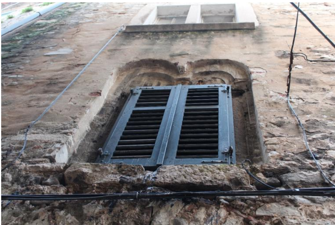
Prilog 17. Izgled bifore ranosrednjovjekovne kuće u Rodriginoj ulici
