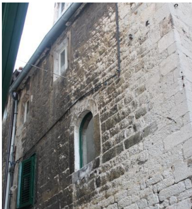
Prilog 21. Primjer zidanja pravlnim klesancima
