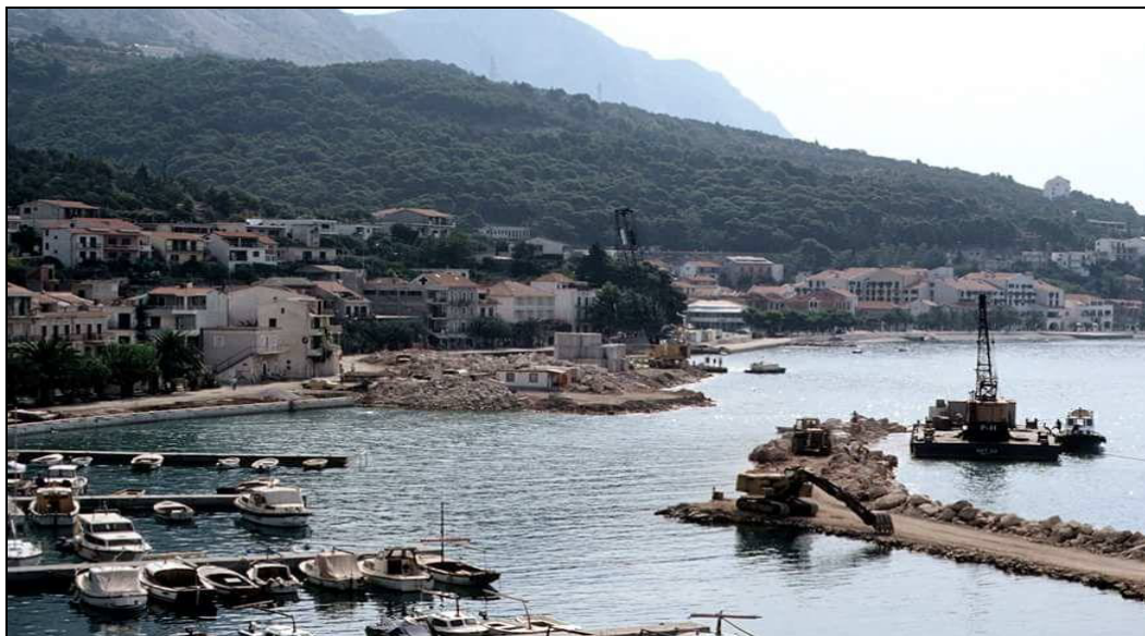
Slika 40. Izgradnja luke u Podgori 546
