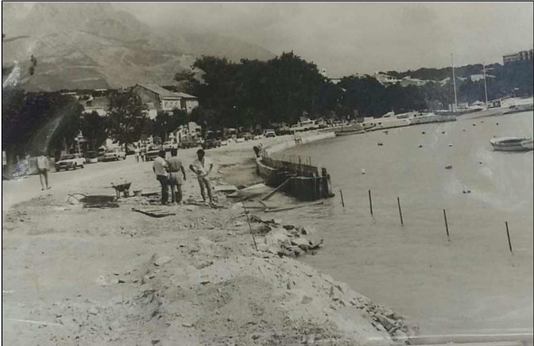
Slika 5. Izgradnja luke u Baškoj Vodi nakon Drugog svjetskog rata 220
