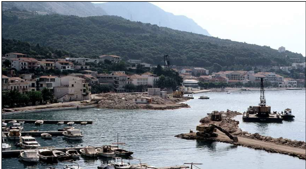
Slika 40. Izgradnja luke u Podgori 546
