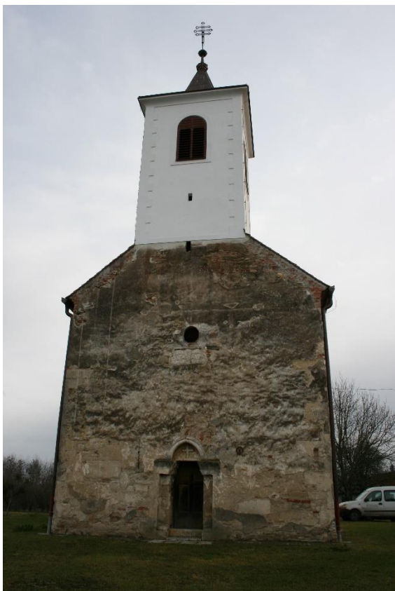
Sl. 13 Križovljan, crkva sv. Križa, zapadno pročelje (foto: Vesna Pascuttini Juraga)
