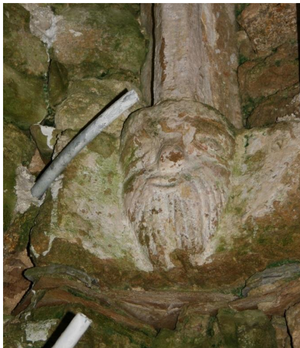
Sl. 80 Očura, crkva sv. Jakova, konzola u zidu svetišta (foto: Vesna Pascuttini Juraga)
