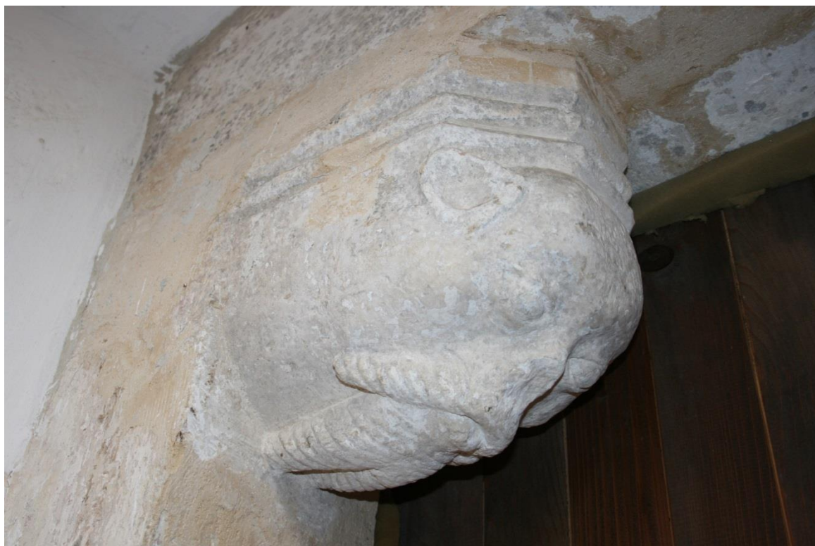
Sl. 96 Lepoglava, portal u unutrašnjosti crkve, Pan (foto: Vesna Pascuttini Juraga)
