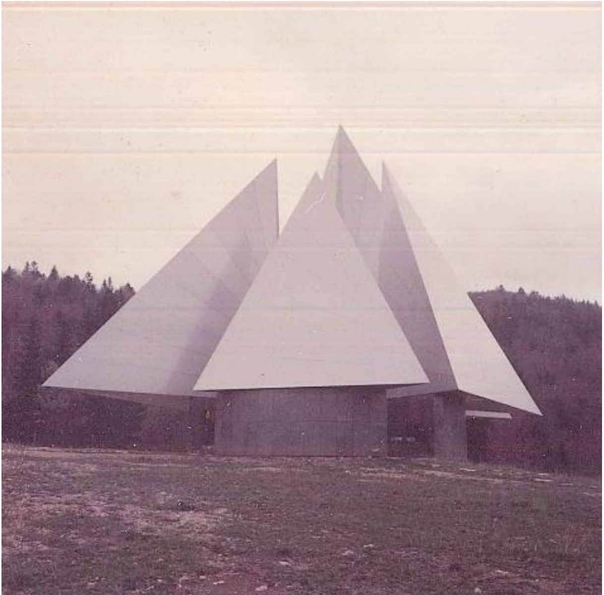
Slika 175. Centralni spomenik spomen-područja Bijeli Potoci – Kamensko, Berislav Radimir, 1981. Izvor: Arhiv Nenad Gattin / Fototetak IPU.
