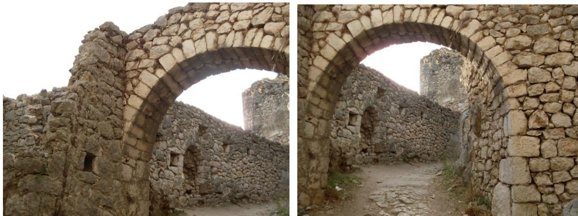
Slike 261 i 262: Obnovljeni ulaz u vanjski obor uz počiteljsku kulu (foto: N. Čuljak).
