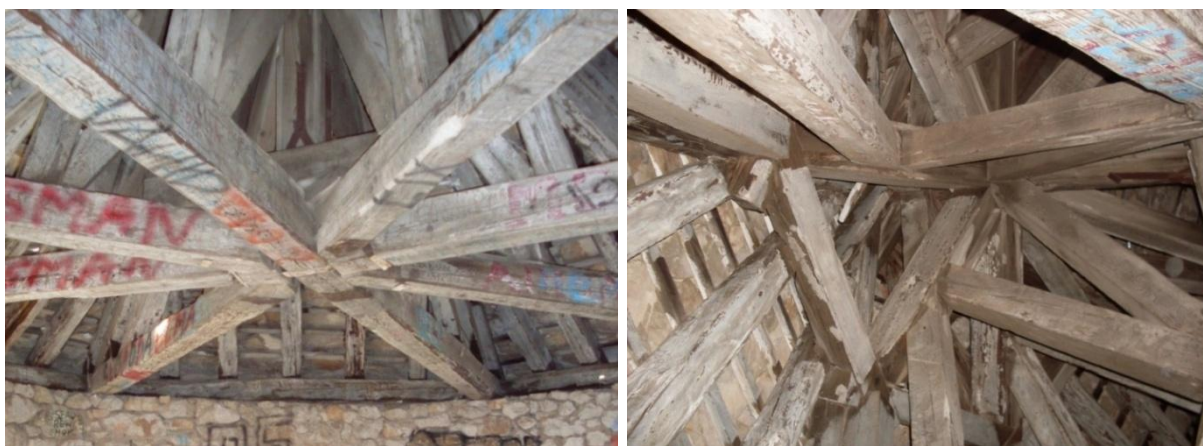
Slike 21 i 22: Današnji izgled rekonstruiranog krovišta počiteljske glavne kule (foto: N. Čuljak).
