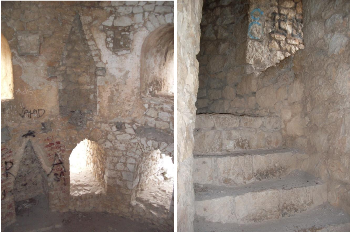
Slike 269 i 270: Pogled na unutrašnjost počiteljskog donžona: lijevo su kamini na različitim katovima i topovski otvori, desno je kružno zidano stepenište unutar kule (foto: N. Čuljak).
