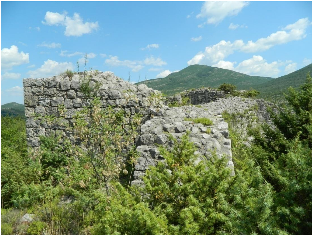
Slika 215: Pogled na ruševine Mičevca zarasle u raslinju (foto: N. Čuljak).
