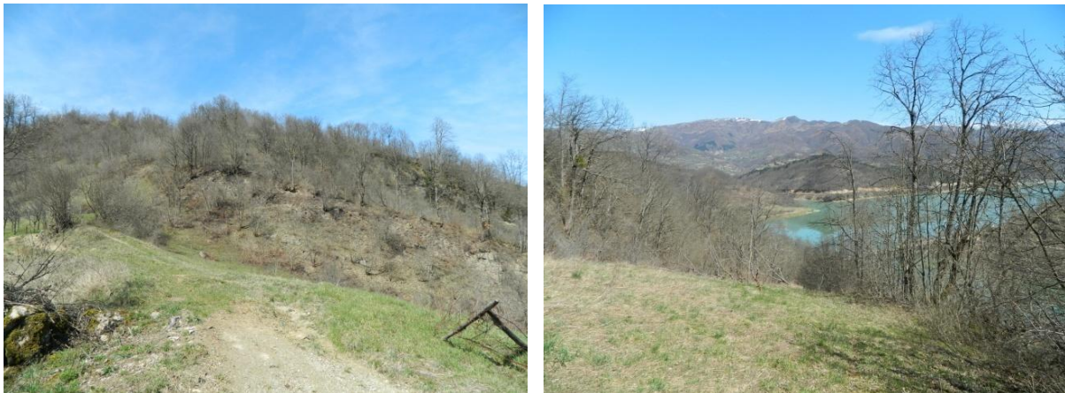
Slike 108 i 109: Velika klizišta ispod Grada i desno – pogled sa Bešika (foto: N. Čuljak).
