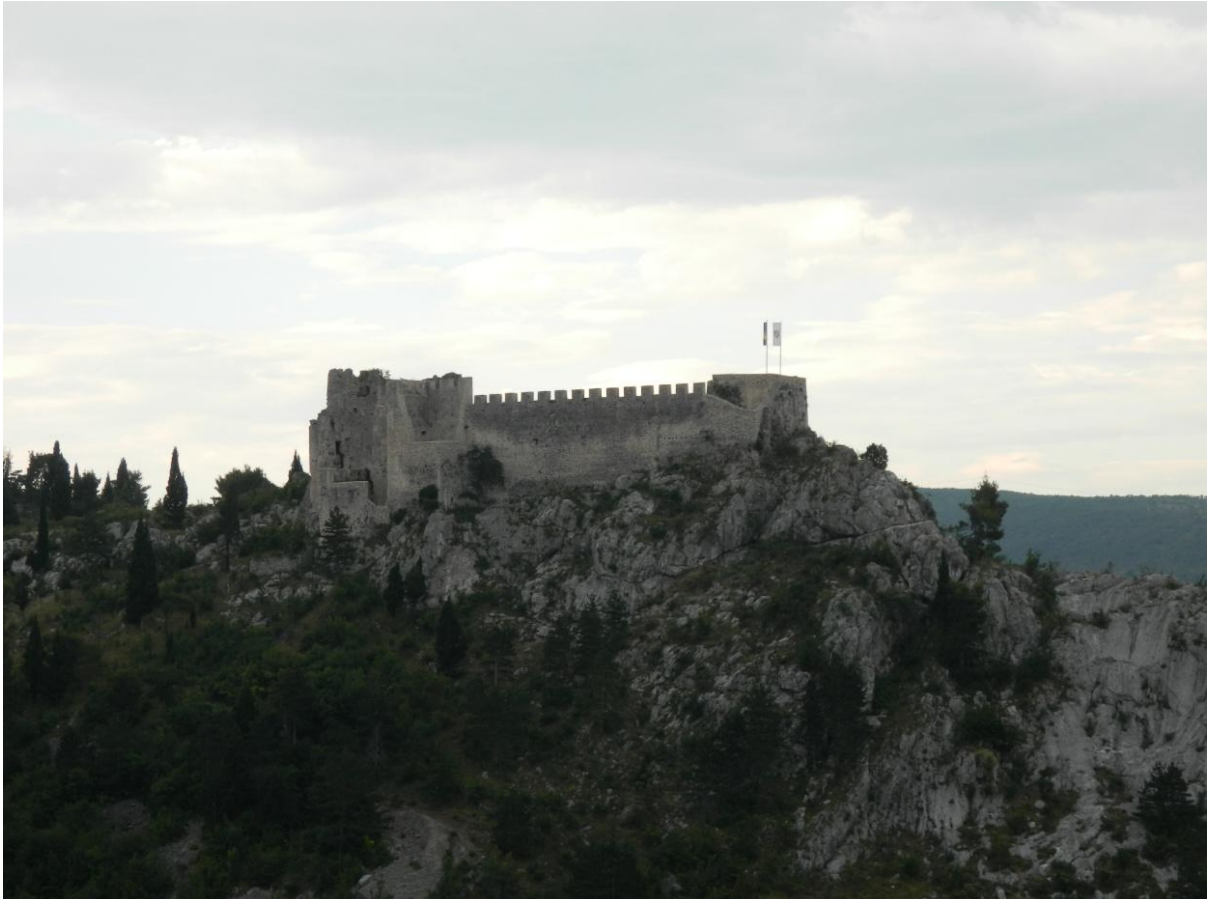
Slika 146 – Pogled na Stjepan grad sa sjeverne strane, sa ceste koja vodi prema Nevesinju (foto: N. Čuljak).
