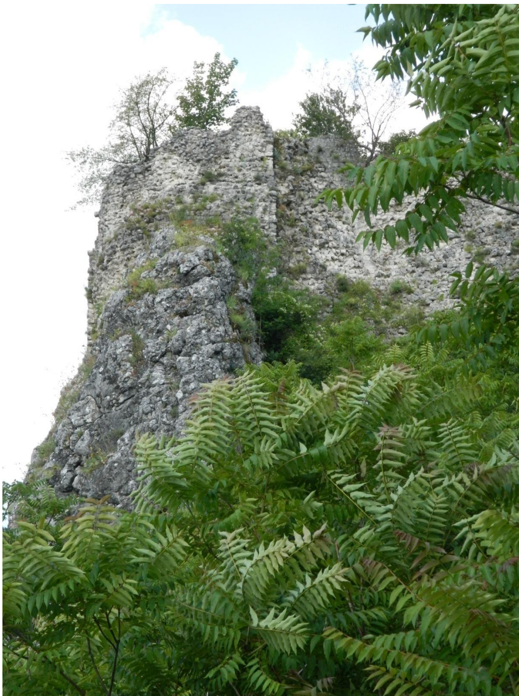
Slika 42: Pogled na kulu "Tamnicu" (foto: N. Čuljak).
