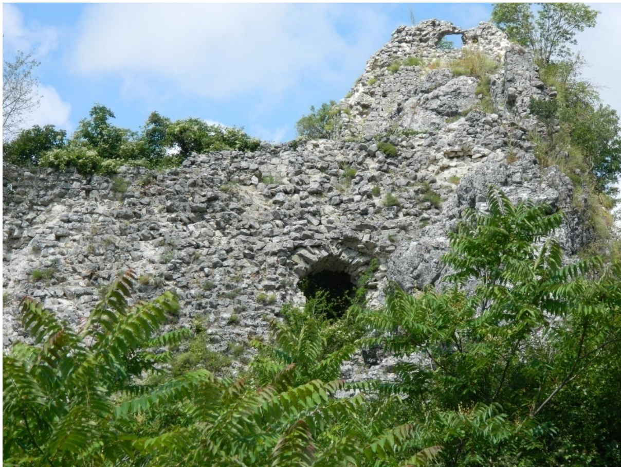
Slika 41: Pogled na gradska vrata (foto: N. Čuljak).
