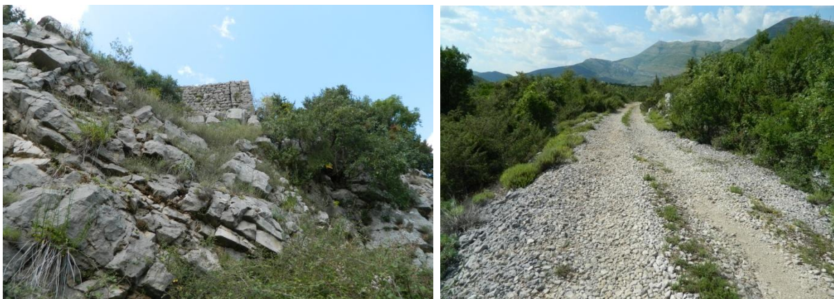
Slike 244 i 245: Lijevo – pogled sa puta na ruševine Mičevca i desno put ispod Mičevca (foto: N. Čuljak).
