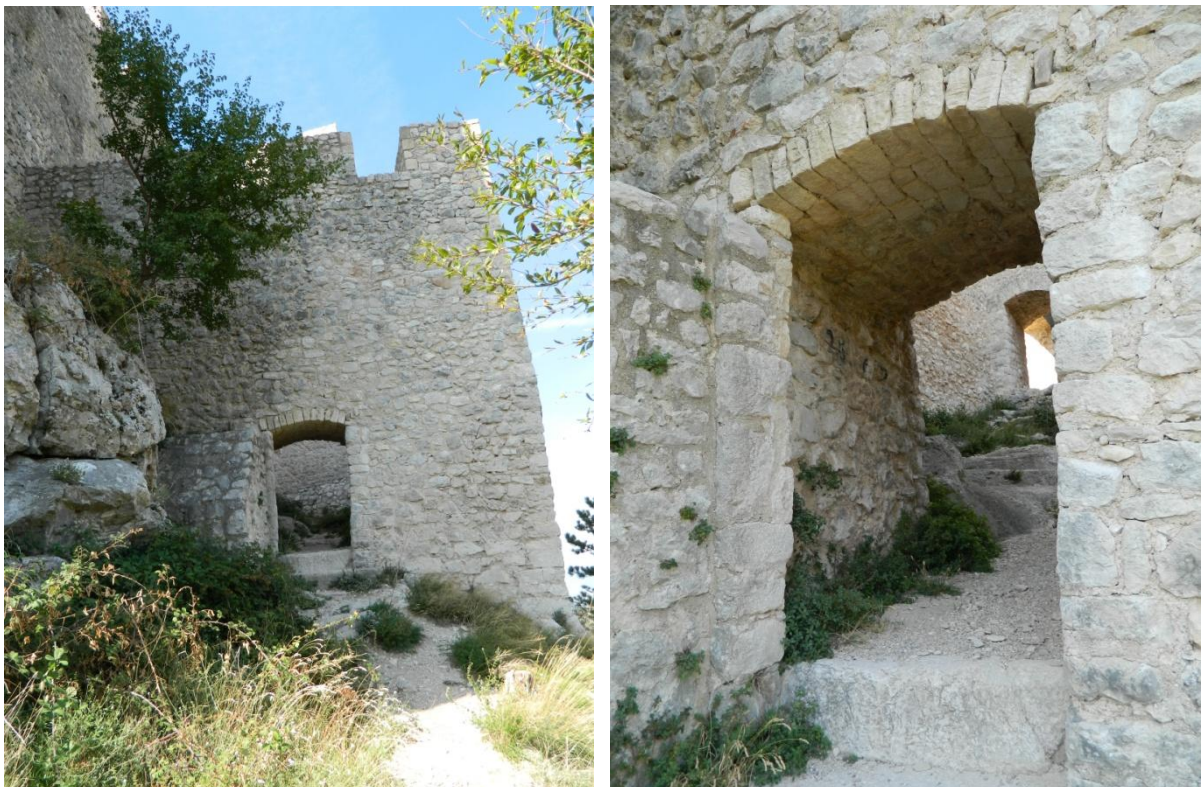
Slike 149 i 150: Ulaz u grad (foto: N. Čuljak).
