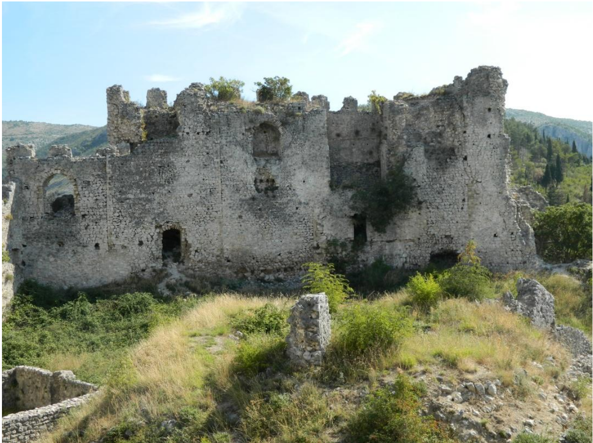
Slika 154: Pogled na kompletan istočni bedem promatran iz unutrašnjosti grada (foto: N. Čuljak).
