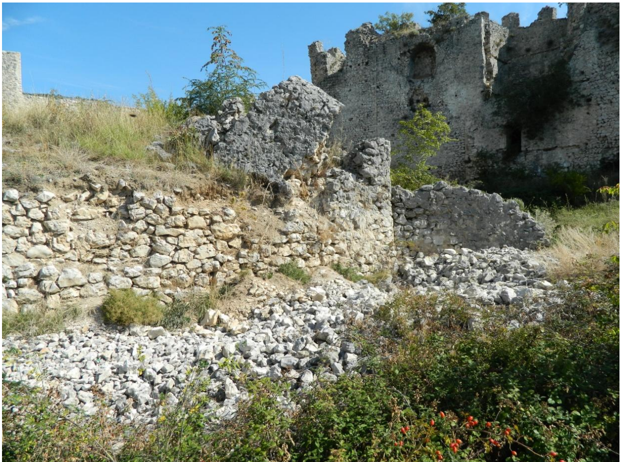
Slika 153: Pogled sa južne strane na ruševine palasa (foto: N. Čuljak).
