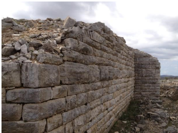
Sl. 10. Dio sjevernog trakta s kulom
