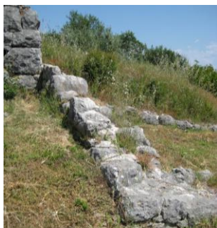
Z trakt (opus siliceum četvrta manira)
