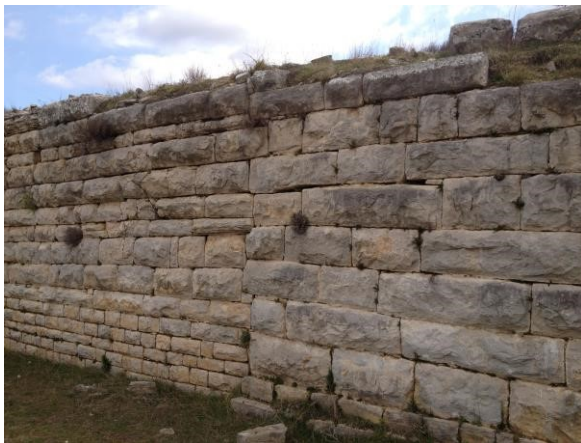
Sl. 9. Zapadni trakt (sjeverni dio)
