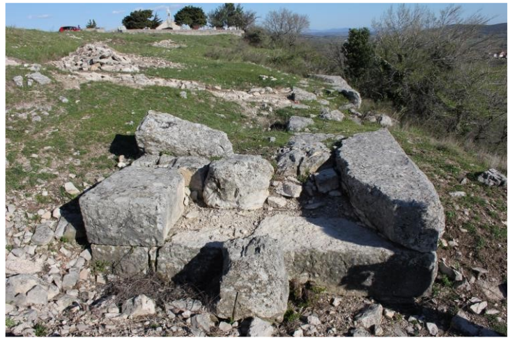
Sl. 12. Vrata (?) i bedem od dva paralelna zida
