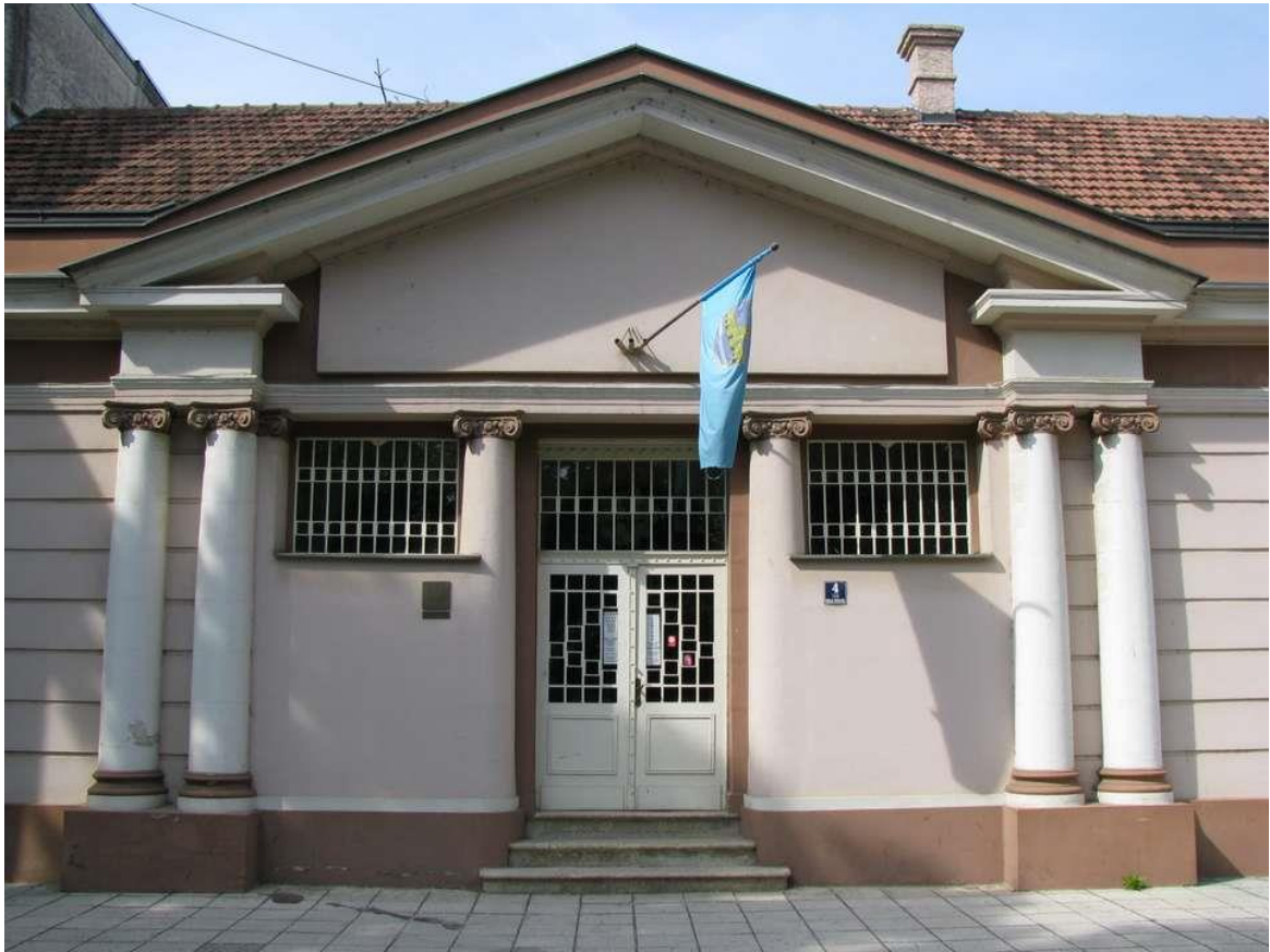
415. Glavno ulično pročelje, detalj (Foto: M. Strugar, 2009.)
