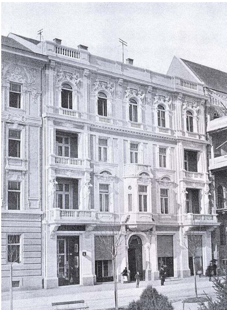
11. Zgrada Hönigsberg (Zagreb, Trg J.J. Strossmayera 8) nakon izgradnje (***(1901.), Kuća gosp. Leona Hönigsberga u Zagrebu , „ Viesti Društva inženjera i arhitekta u Hrvatskoj i Slavoniji “, 22 (4): prilog 3, Zagreb)
