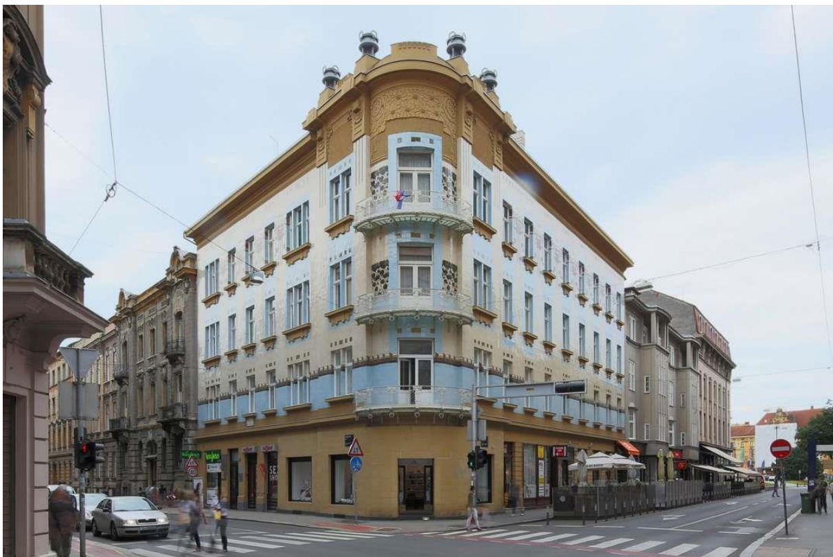
264. Zgrada Kallina (Zagreb, Gundulićeva 20/Masarykova), ulično pročelje (foto: Z. Bogdanović, 2015.)
