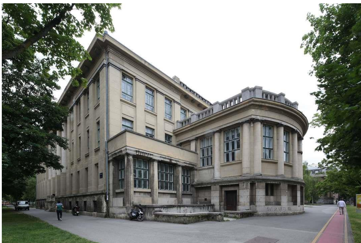
446. Kraljevski sveučilišni ludžbeni zavod (Zagreb, Marulićev trg 20), pogled sa sjeveroistoka sa sjevernim pročeljem u prvom planu (foto: Z. Bogdanović, 2015.)
