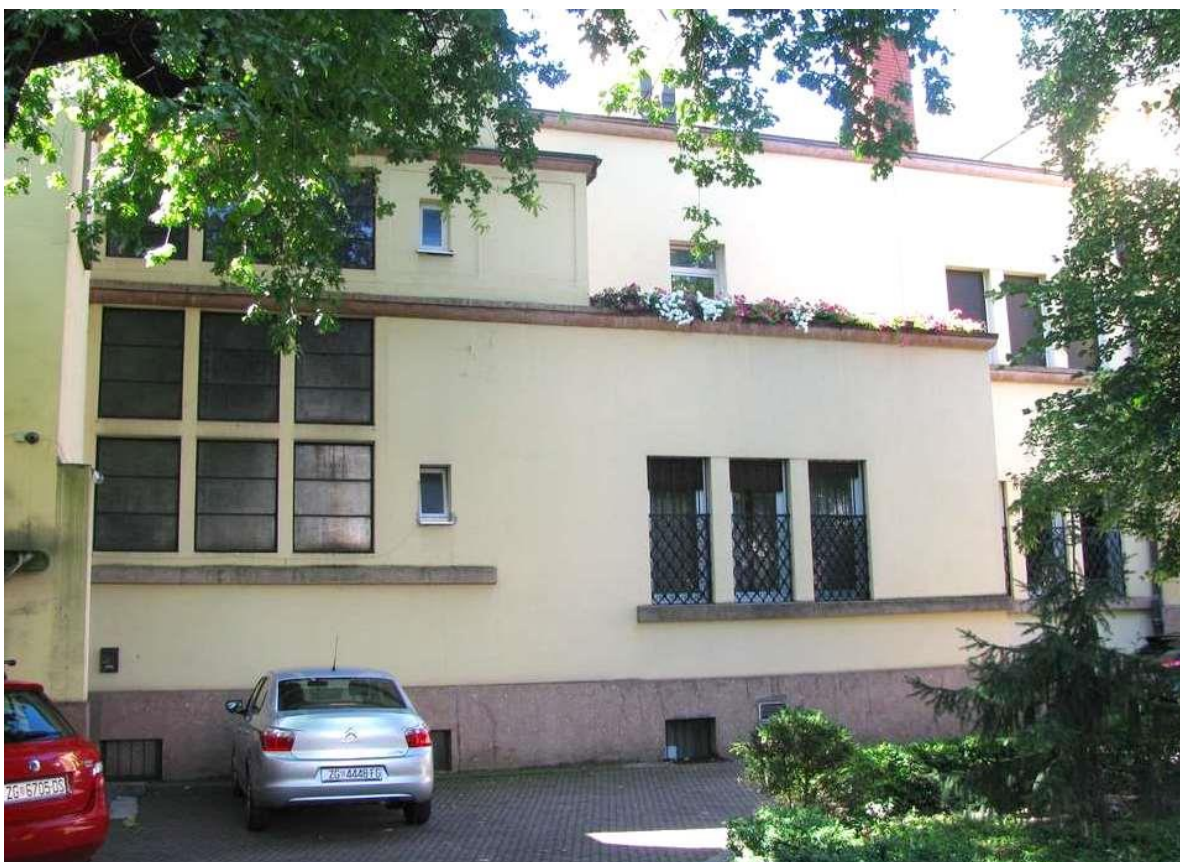
597. Župni stan, pročelje na Petretičevom trgu (foto: M. Strugar, 2014.)
