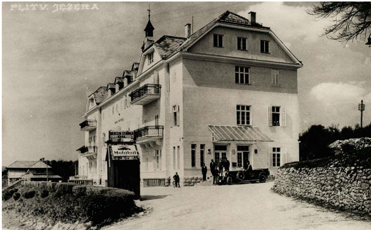
506. Hotel Plitvice (Plitvička jezera), izgled nakon dogradnje 1921.-1922., glavna hotelska zgrada, (Arhiva Nacionalnog parka Plitvička jezera; IVANUŠ, 2010: 122-135)
