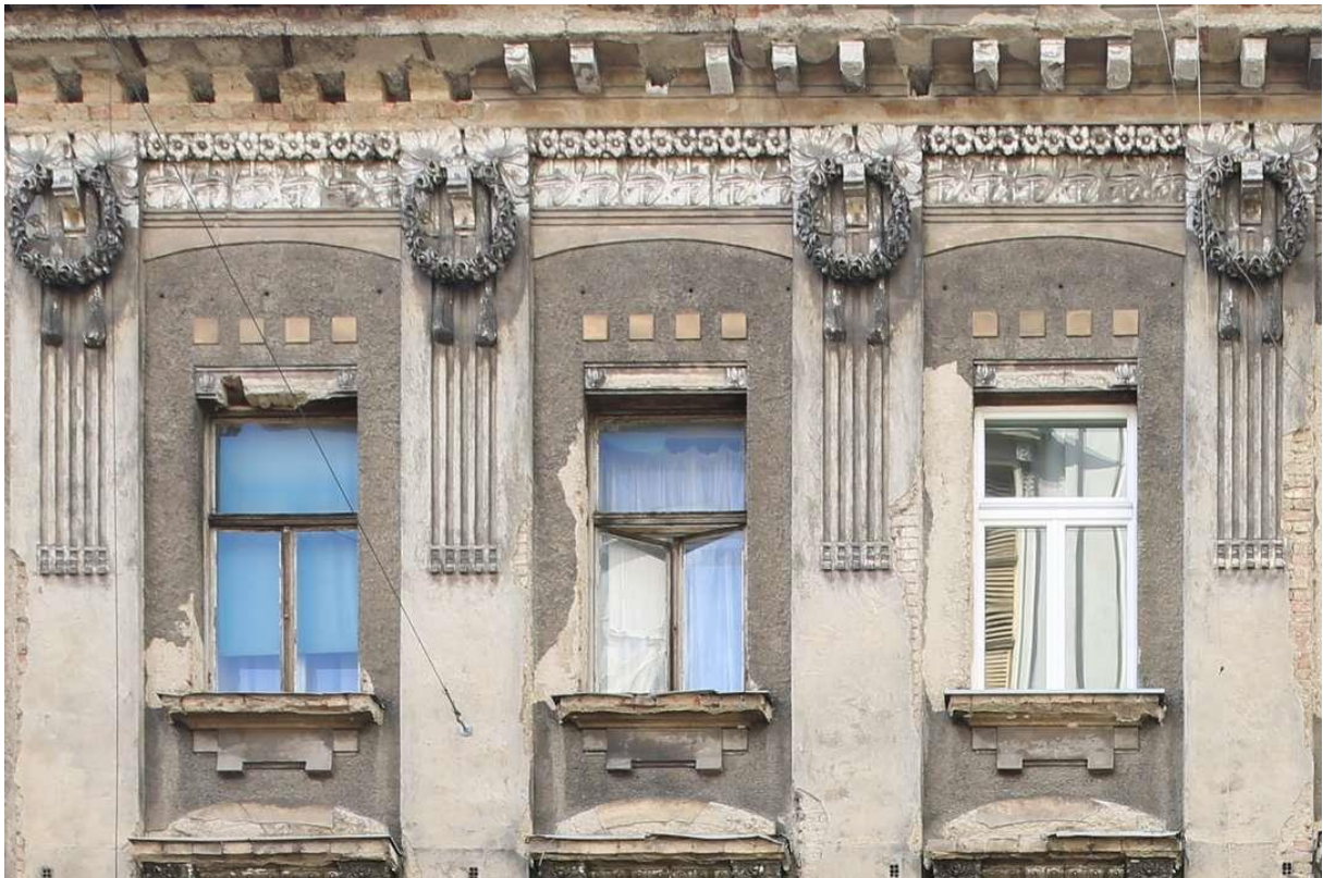
255. Zgrada Majdak (Zagreb, Palmotićeveva 50), ulično pročelje, detalj (foto: Z. Bogdanović, 2015.)
