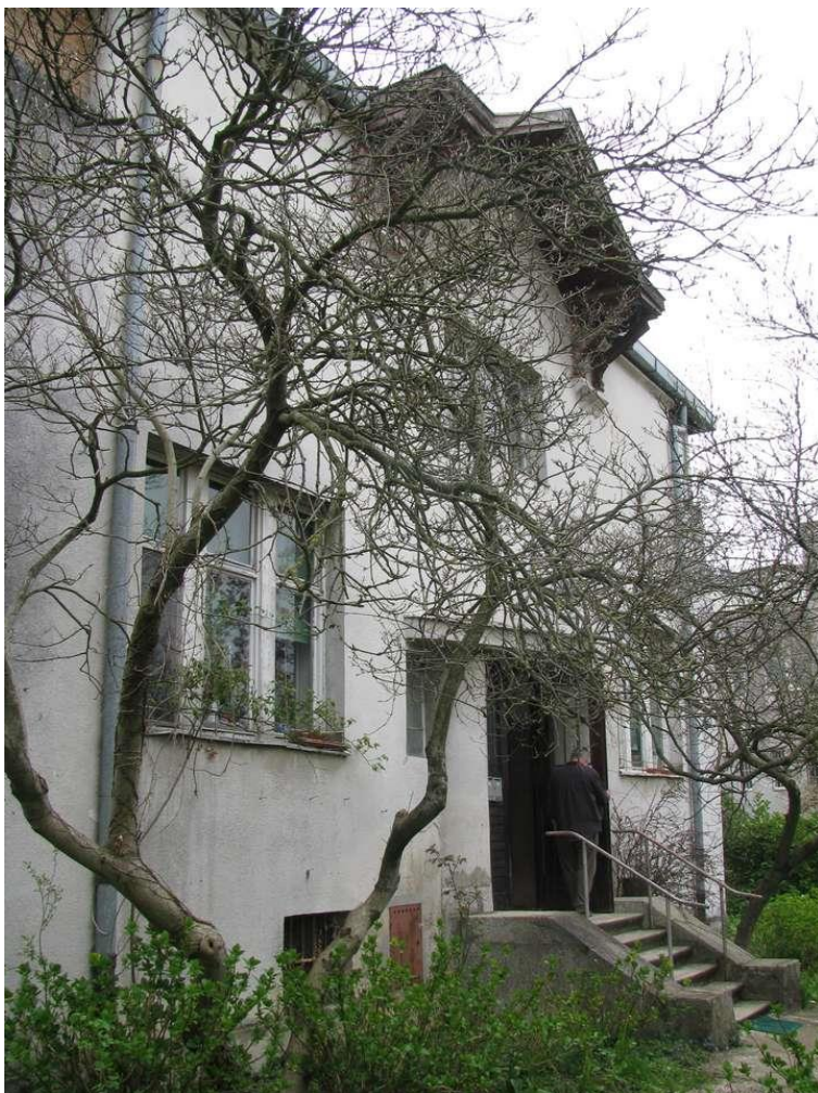
378. Današnje stanje glavnog pročelja koje je u potpunosti izmijenjeno. Naziru se izvorni elementi na ulaznom dijelu, prozorima u prizemlju i drvenim motivima u zoni krova (foto: M. Strugar, 2015.)
