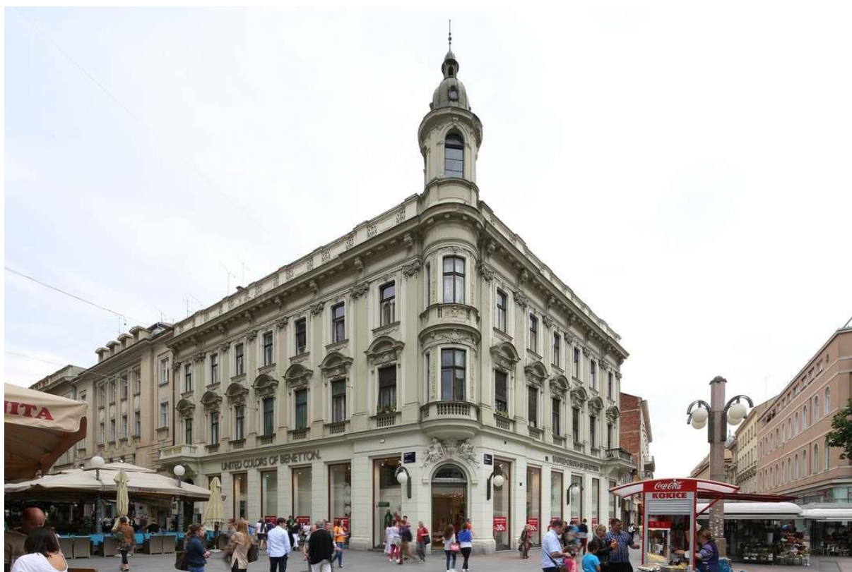
195. Zgrada Farkaš (Zagreb, Bogovićeva 9), ulična pročelja, današnje stanje (foto: Z. Bogdanović)
