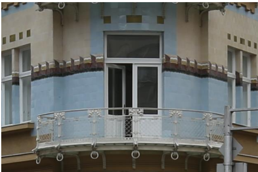
132. Zgrada Kallina (Zagreb, Gundulićeva 20/Masarykova), friz šišmiša na keramici pročelja (foto: Z. Bogdanović, 2015.)
