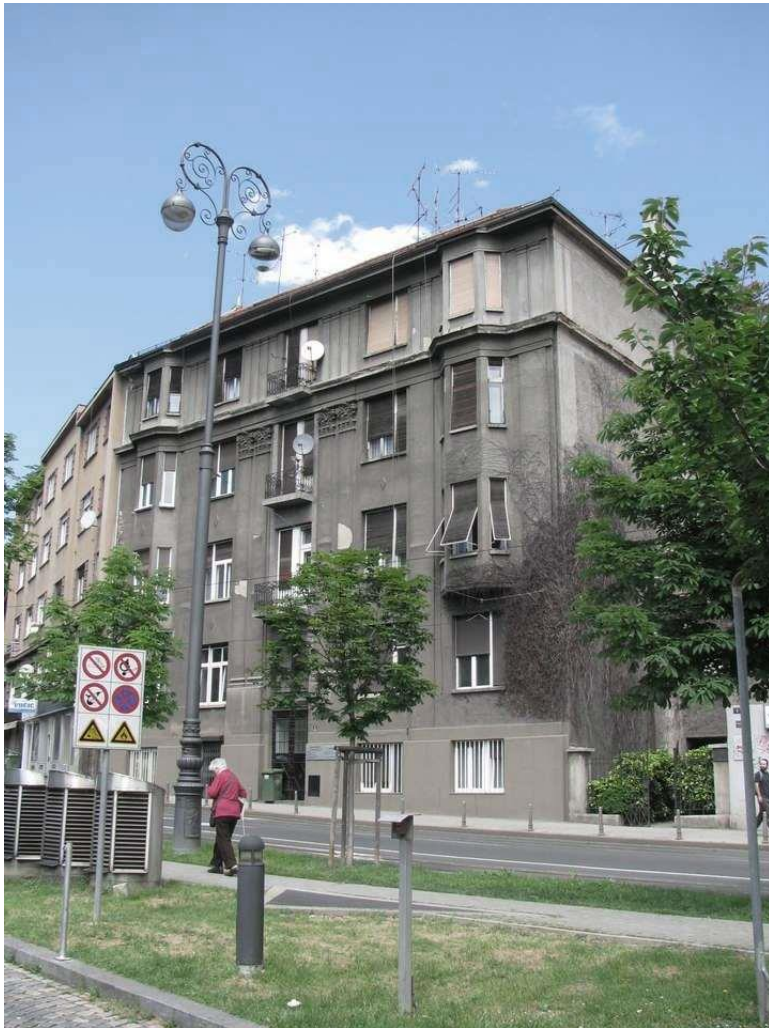
421. Zgrada Moguš, današnje stanje, izvedeno prema izmijenjenom projektu (foto: M.Strugar, 2013.)
