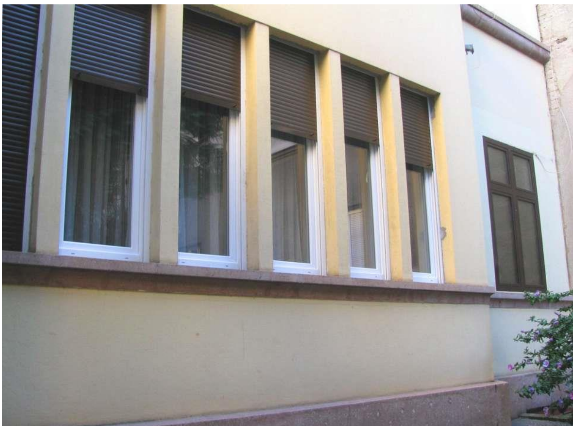
596. Župni stan, detalj pročelja u Vlaškoj ulici (foto: M.Strugar, 2014.)
