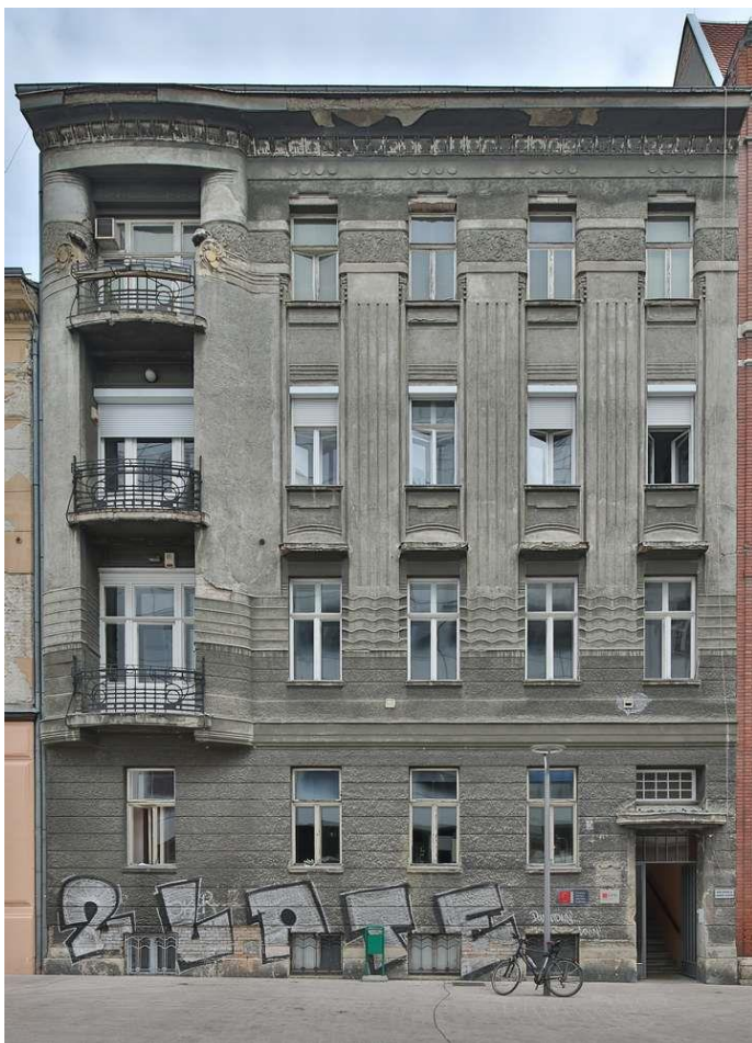
59. Zgrada Rozsary (Zagreb, Kurelčeva 3), ulično pročelje (foto: Z.Bogdanović, 2015.)
