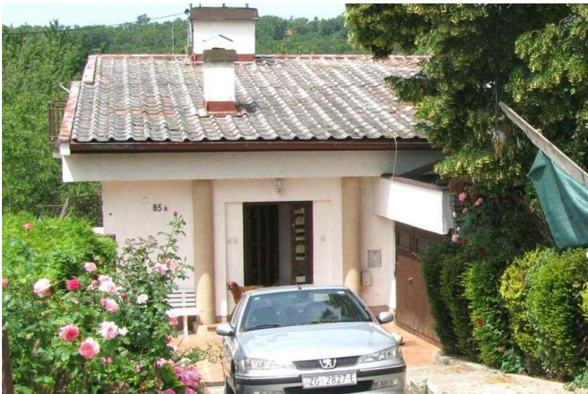
128. Kuća V. Bastla (Zagreb, Tuškanac 85 a), pogled na glavno ulazno pročelje prema Tuškancu, današnje stanje, u velikoj mjeri izmijenjeno u odnosu na izvorno (foto: M. Strugar, 2014.)
