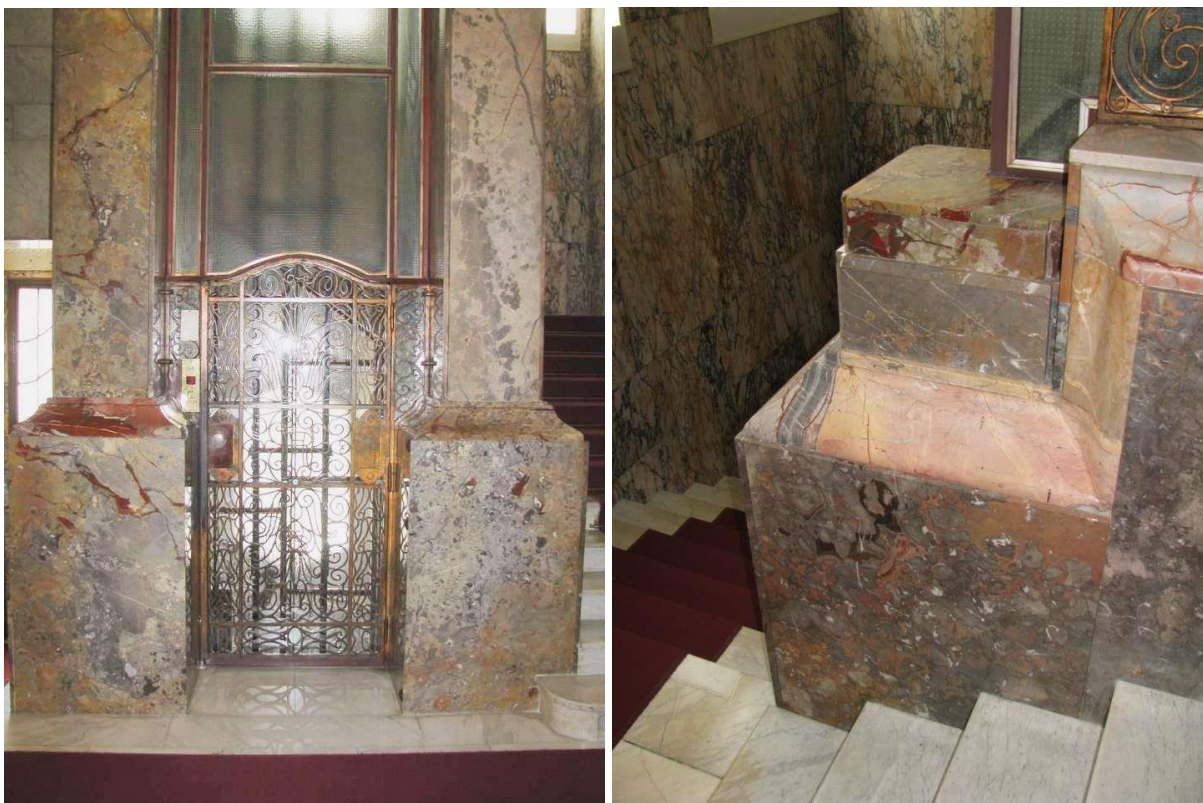
105. i 106. Adaptacija stubišta palače Vranyczany (Zagreb, Trg Nikole Zrinskog 19), ulaz u dizalo i detalj stubišta (foto: M. Strugar)
