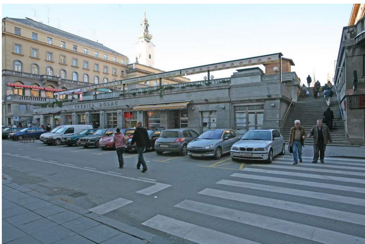
558. Pogled na južno pročelje podzemne tržnice; u pozadini lijevo Bartulićeva kuća (Dolac 1/Tkalčićeva 2) i zvonik crkve sv. Marije (foto: Zoran Bogdanović, 2007.)
