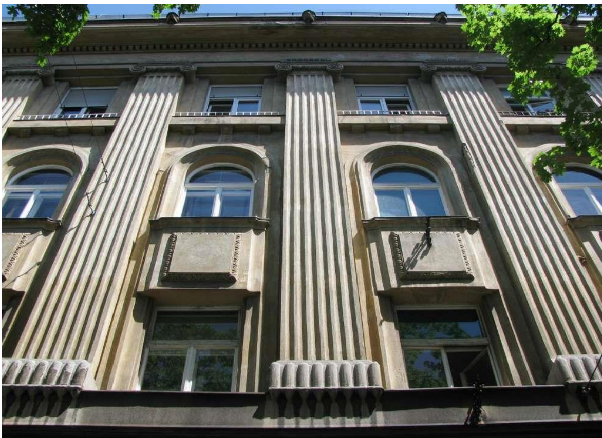
495. Ulično pročelje, detalj (foto: M. Strugar, 2013.)
