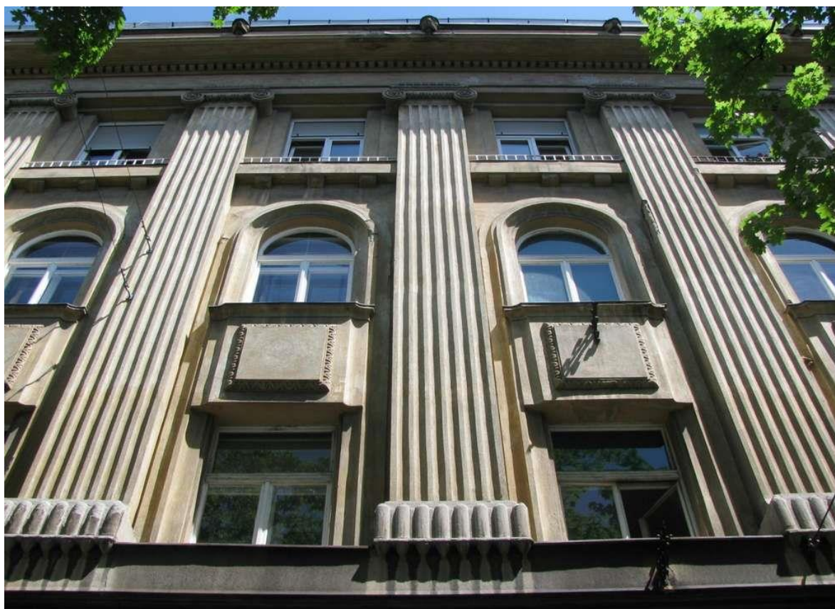
495. Ulično pročelje, detalj (foto: M. Strugar, 2013.)
