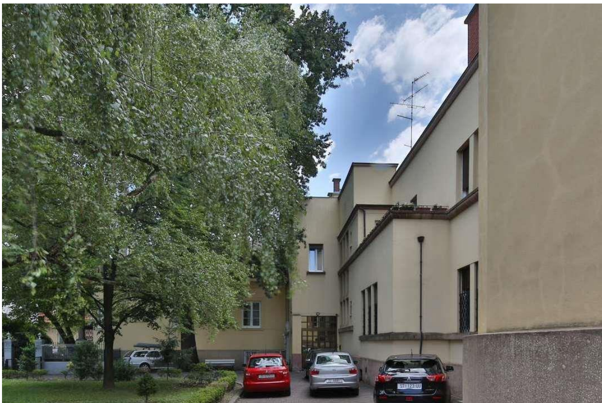
123. Župni stan i ured župe sv. Petra (Zagreb, Vlaška 93), pročelje prema Petretičevom trgu s dijelom svetišta crkve u prvom planu desno(foto: Z. Bogdanović, 2015.)
