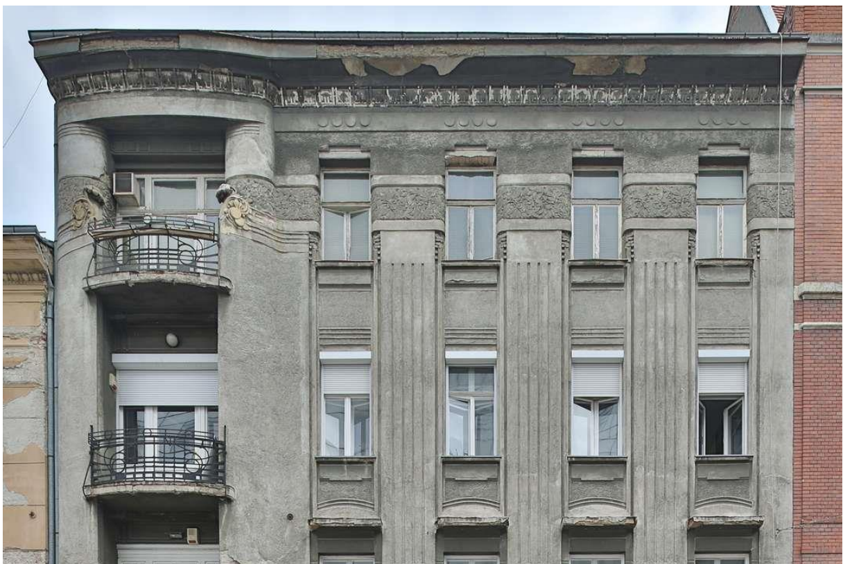
310. Zgrada Rozsay (Zagreb, Kurelčeva 3), pročelje, detalj (foto: Z.Bogdanović, 2015.)
