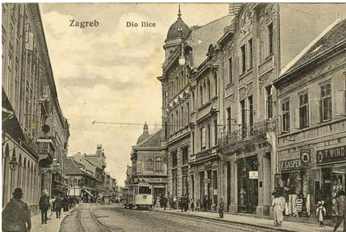
15. Zgrada Pečić (Zagreb, Ilica 43, 1899.), na razglednici s početka dvadesetog stoljeća, druga s desne strane (privatno vlasništvo)
