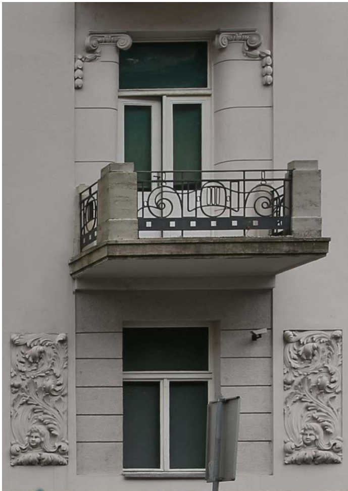
414. Detalj pročelja (foto: Z. Bogdanović, 2015.)
