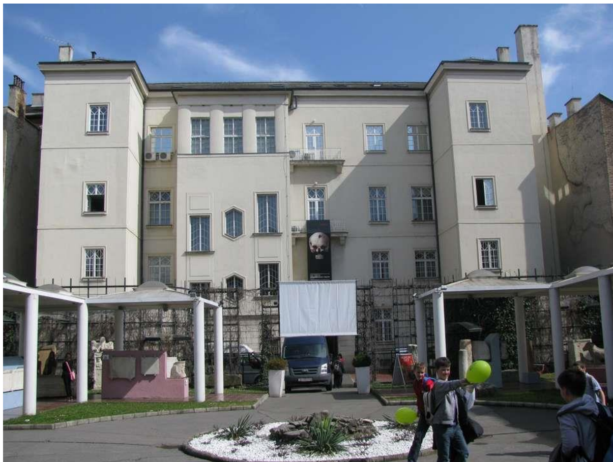
462. Dvorišno pročelje s rizalitom dograđenog stubišta (foto: M. Strugar, 2014.)
