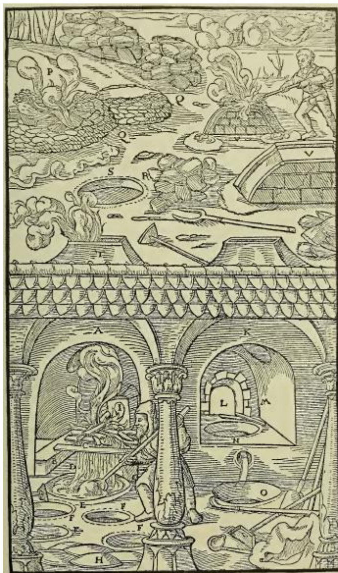
Slika 16 – Posebne peći za taljenje olovne rude: A – peć Karnia; K – peć Saksonaca; P – ognjište Vestfalijevaca; V – peći Poljaka (G. AGRICOLA, 1556, 393.)
