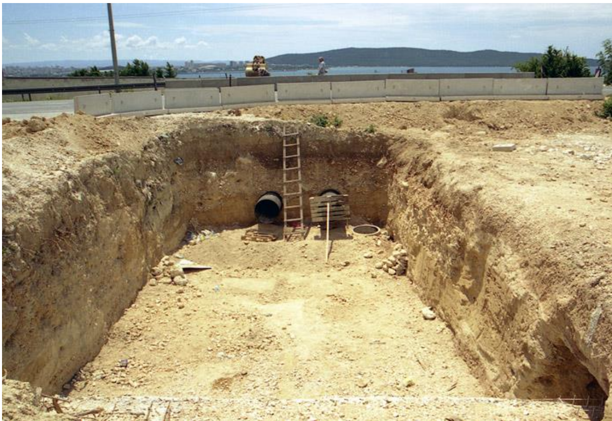
Slika 24: Glavni cjevovod Kaštela - Trogir - iskop ispod magistrale ( Izvor: URL11 ).
