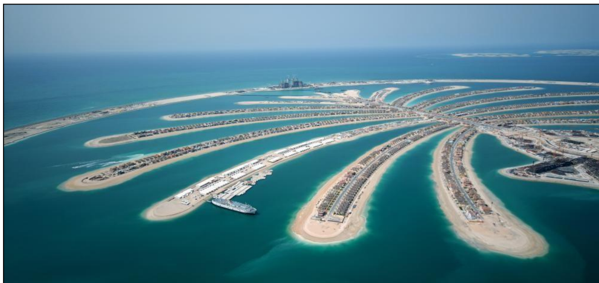
Slika 1. Nasipavanje u Perzijskom zaljevu s ciljem izgradnje stambene i gospodarske infrastrukture (izvor: URL 1, 2015.)
