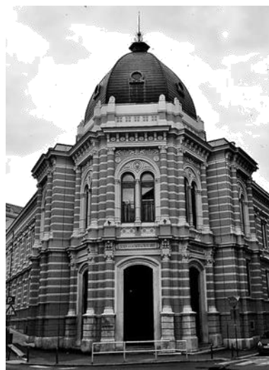
40. slika: Zgrada Scuola maschile i Liceo Scientifico današnja Scuola Elementare i Media Superiore Italiana Rijeka
