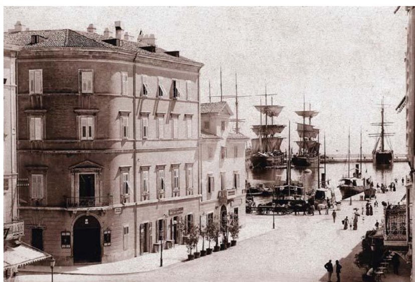
67. slika: Casa Rotonda – građevina s lijeve strane na povijesnoj fotografiji Rijeke s početka 20. stoljeća.
