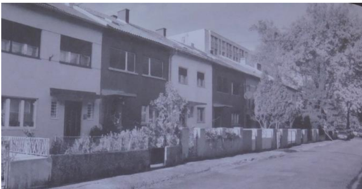
Slika 16. Niz stambenih kuća naselja Prve hrvatske štedionice (izvor: D. RADOVIĆ MAHEČIĆ, 2002., 178.)
