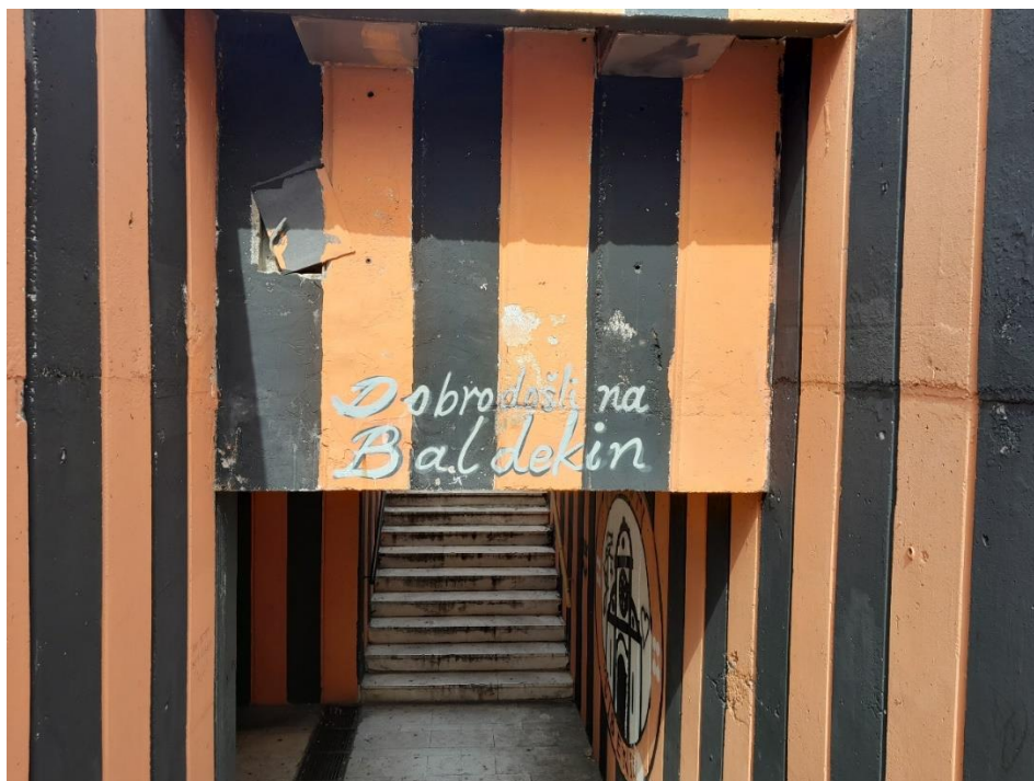
Slikovni prilog 4. Ulaz u pothodnik kojim se pristupa sportskoj dvorani „Baldekin“. Autorica fotografije Ana Madunić. Šibenik, travanj 2023.
