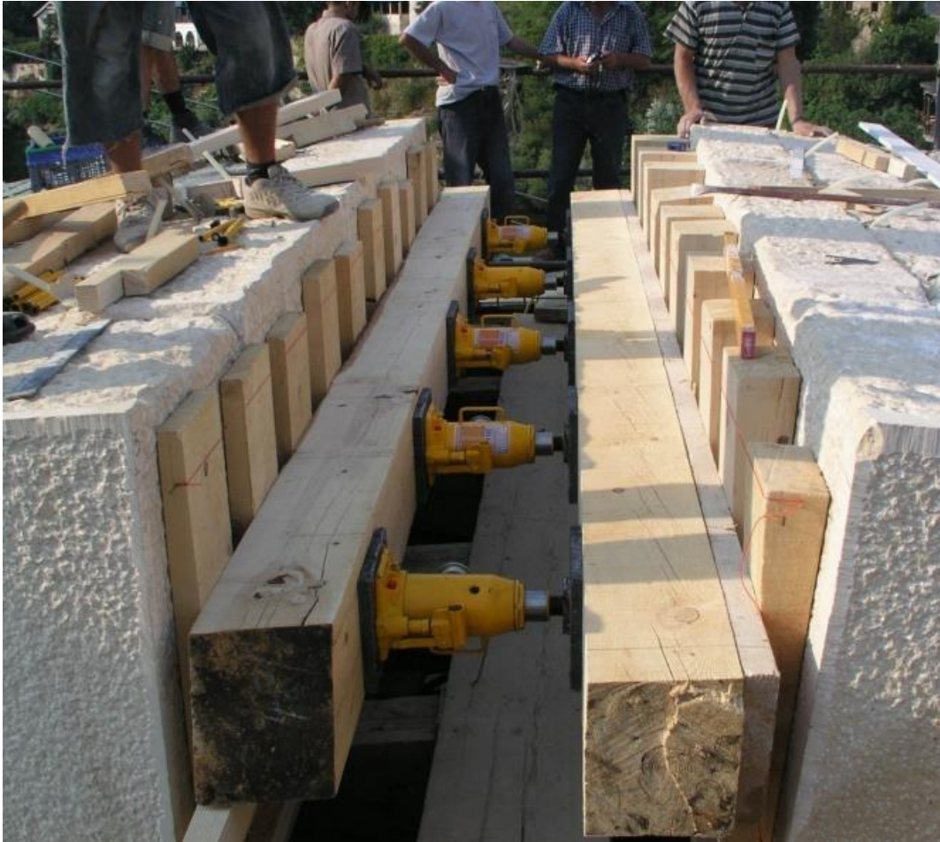
Slika 14. Hidrauličke preše u svrhu razupiranja tjemena luka (Izvor: M. Glibić, Priče o Starom mostu, 2018., 50)
