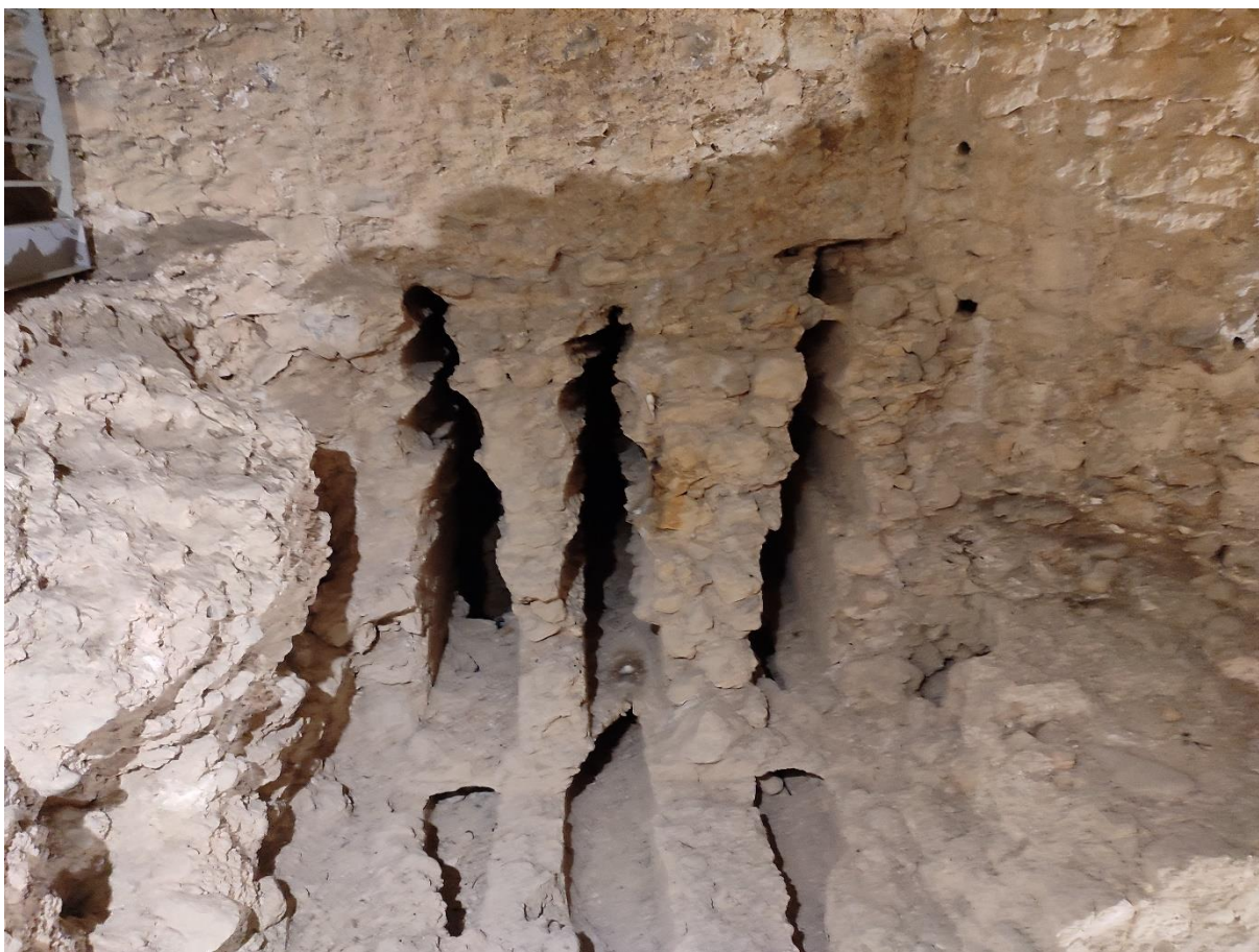
Slika 8. Masivni kamen s udlagama i ostacima drvenih greda in situ , Muzej Hercegovine Mostar, Odjel Stari Most (Izvor: Lucija Radoš)
