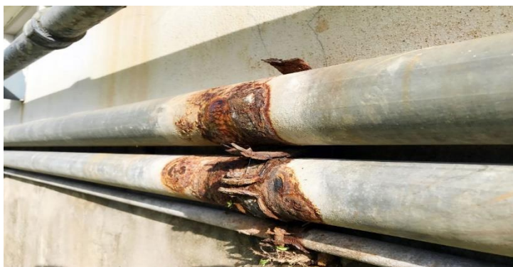
Slika 13. Zahrđalost cijevovoda (Izvor: https://www.blog.eddyfi.com )
