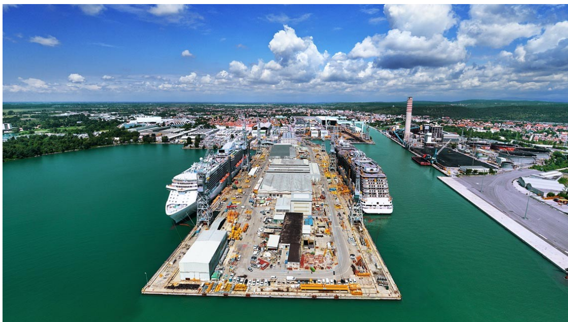
Slika 8. Brodogradilište Fincantieri u Trstu, Italija
