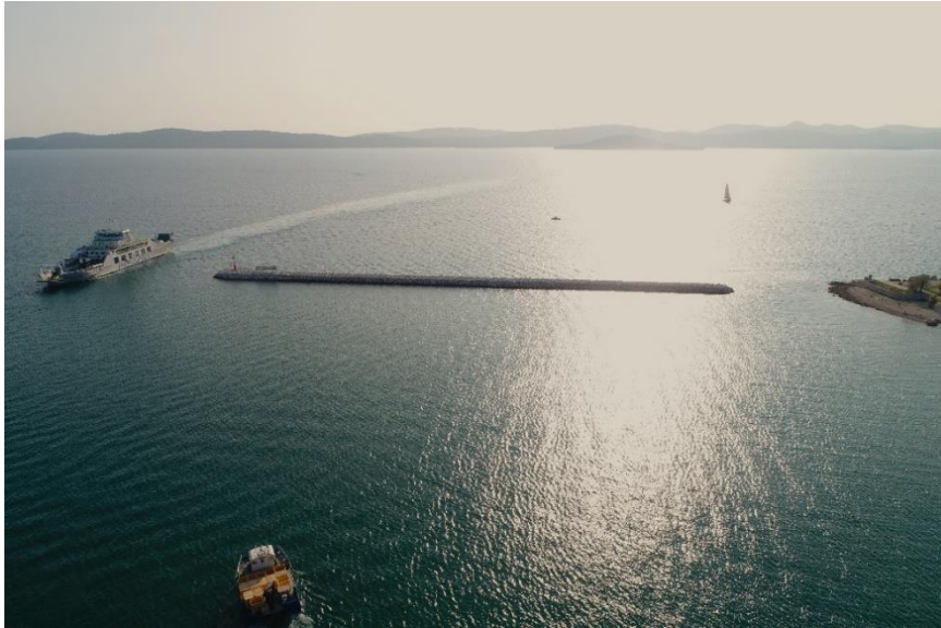
Slika 6. Ulaz u luku između valobrana (školjere) i rt-a Punta Bajlo
