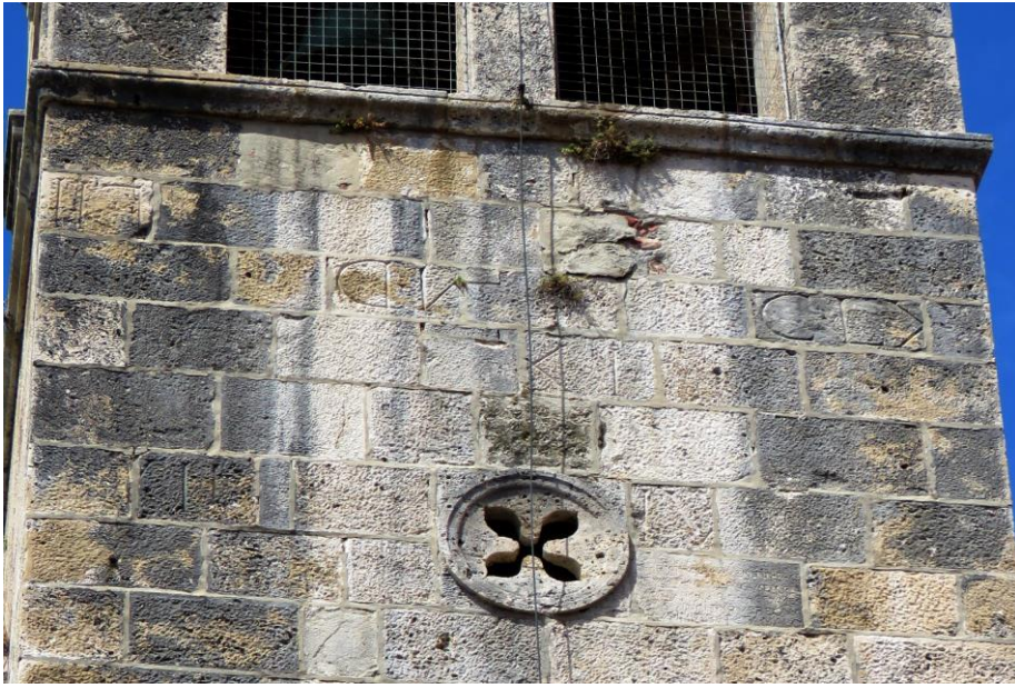
Slika 76. Kameni blokovi poljudskog zvonika s uklesanim rimskim brojkama
