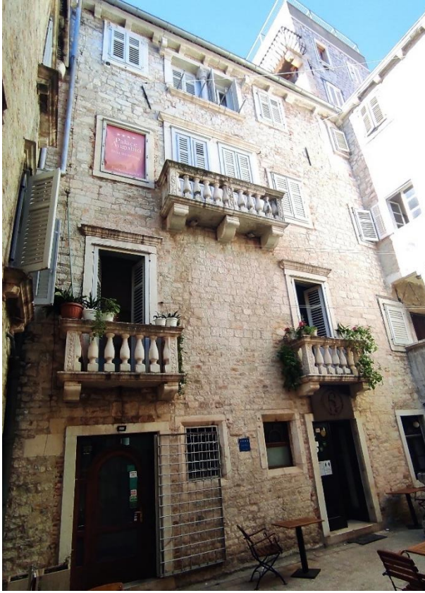
Slika 123. Zapadno dvorišno pročelje palače Augubio, Split
