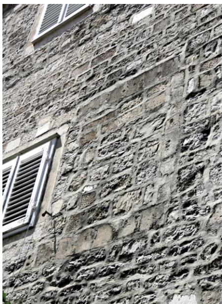
Slika 45. Zazidani prozor prvog kata sjevernog samostanskog krila
