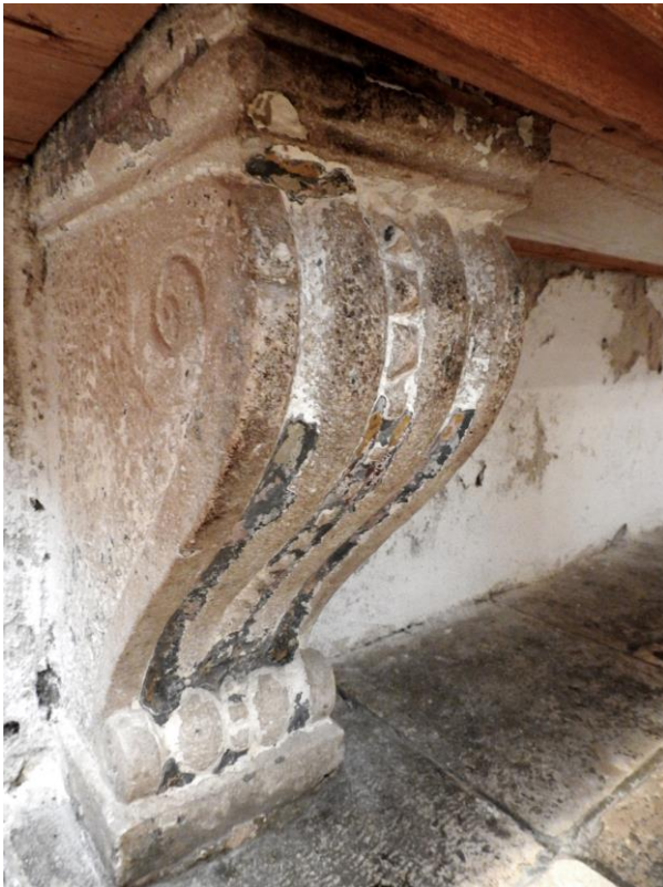
Slika 179. Konzola klupe poljudskog refektorija
