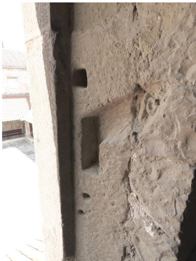
Slika 55. Bočni utori dovratnika ulaza prvog kata poljudske kule
