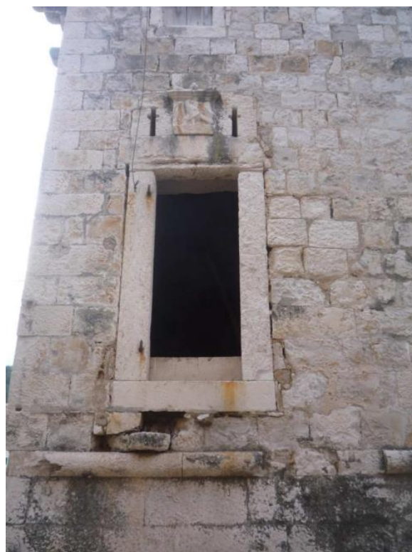
Slika 54. Otvor na prvom katu kule Aquila (sredina 16. st.), Pučišća
