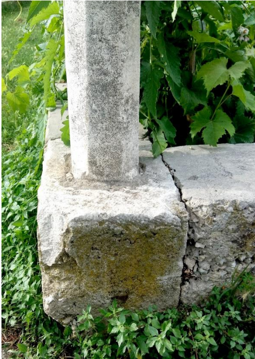
Slika 208. Kameni nosači poljudskih stupića
