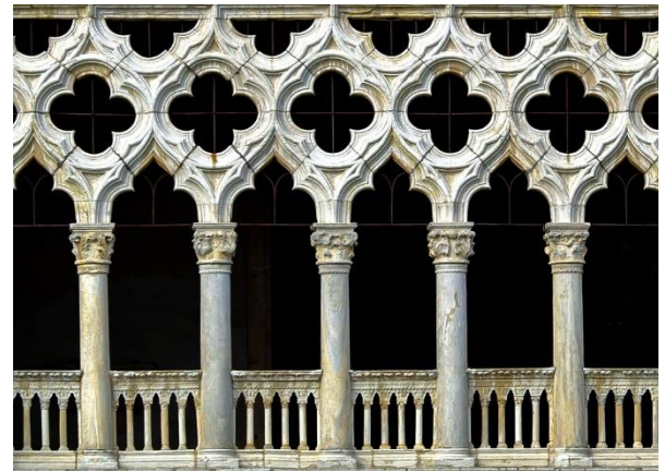
Slika 173. Balustrada palače Ca`d`Oro (1428.-1430.), Giovanni i Bartolomeo Bon
