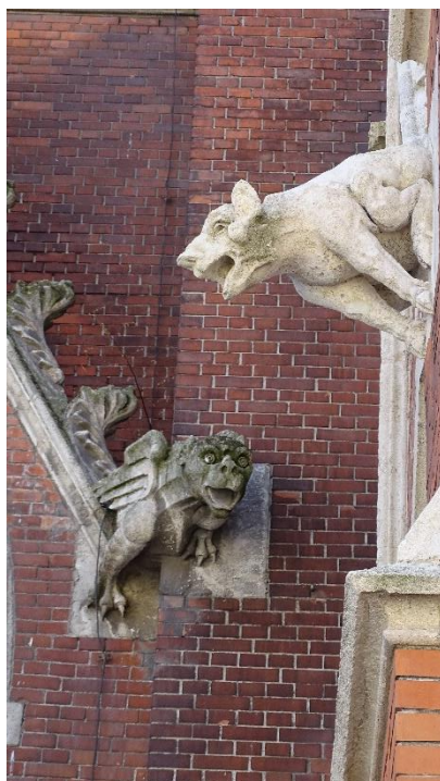
Prilog 17. Obnovljeni i neobnovljeni detalji konkatedrale na sjevernom pročelju. Autor fotografije: Karla Buzinac.
