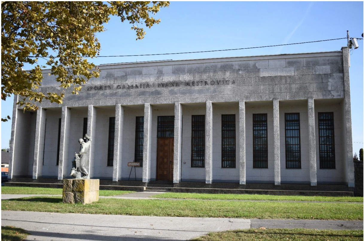
Slika 32 Fotografija sjevernog pročelja (Izvor: Kristina Slobodanac)
