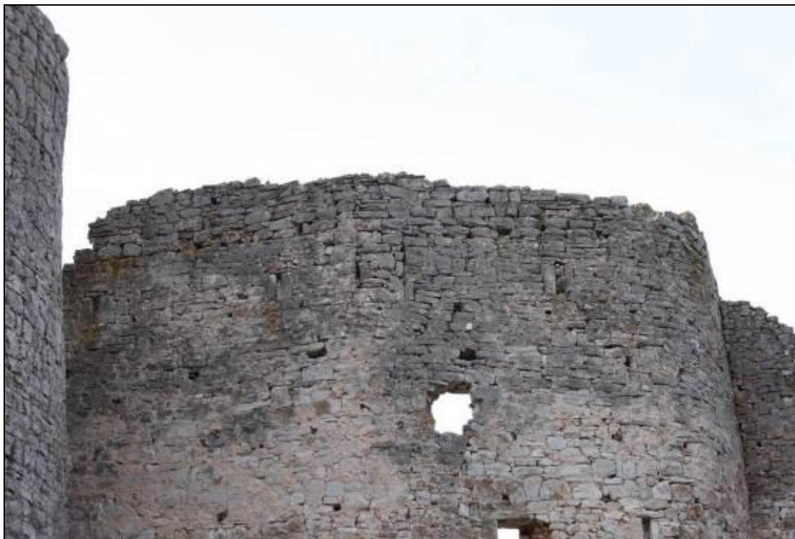
Slika 19. Glavaš, zazidano krunište
