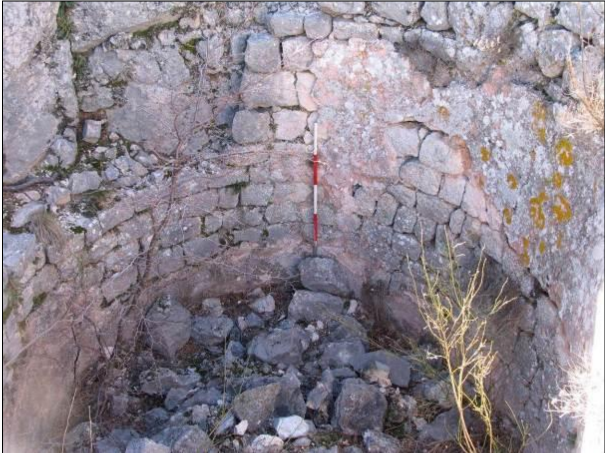
Slika 92. Proložac – Badnjevice, cisterna za vodu
