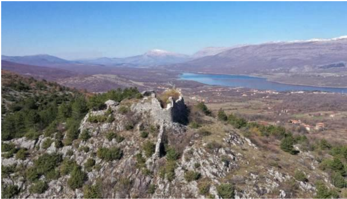
Slika 39. Travnik, pogled s jugoistoka
