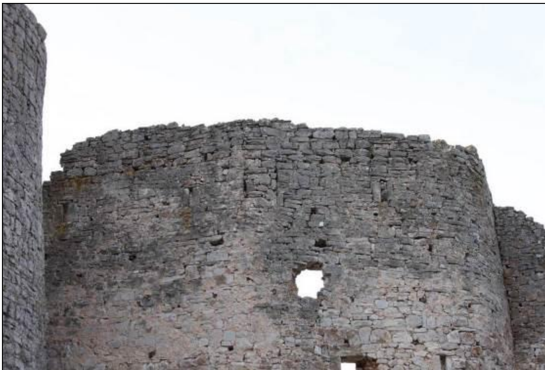
Slika 19. Glavaš, zazidano krunište
