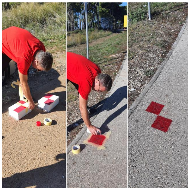
Slika 6 Označavanje orijentacijskih i kontrolnih točaka
