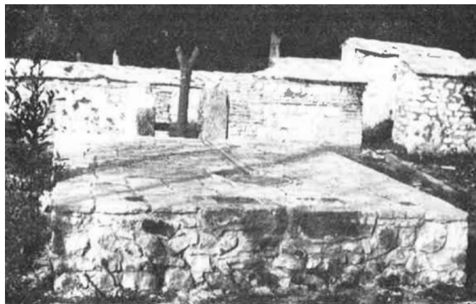
Sl. 252. Rekonstruirani kameni podij ( forum ) torkulara s arejom i kanalom za otjecanje ulja (preuzeto: Bojanovski, 1969b, 39)
