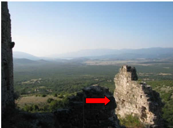
Sl. 87. Zid SJ 12 Prostorije 1 na zapadu utvrde
