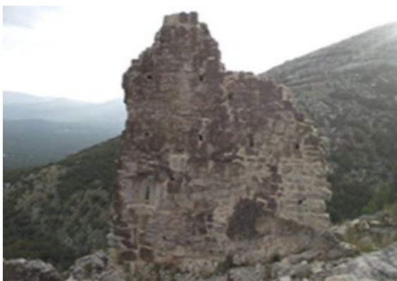
Sl. 129. Pogled s istoka na zid SJ 12 poslije konzervatorskih radova
