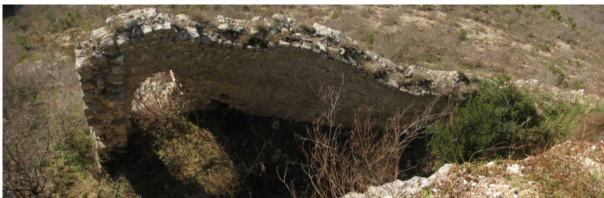
Sl. 143. Obrambeni zid na južnoj strani utvrde
