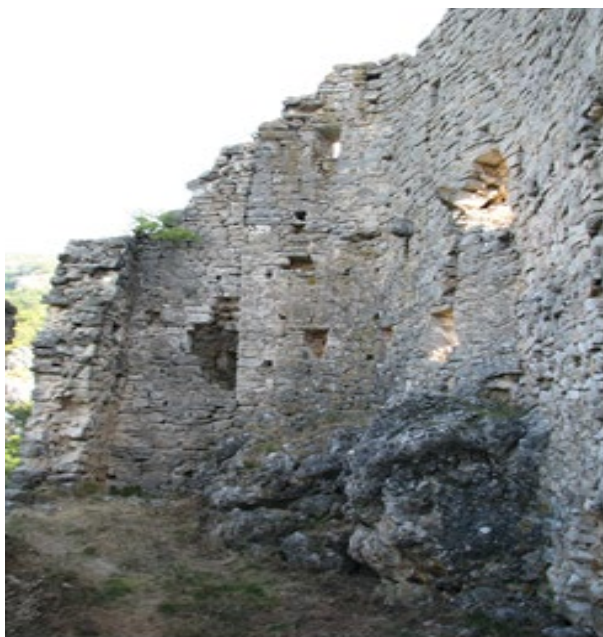
Sl. 75. Pogled na istočni zid SJ 09 Prostorije 2
