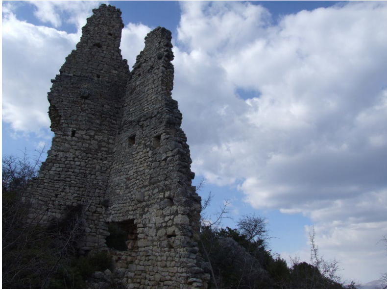
Sl. 140. Ostaci dvaju zidova zgrade na sjeveru i sjeverozapadu utvrde
