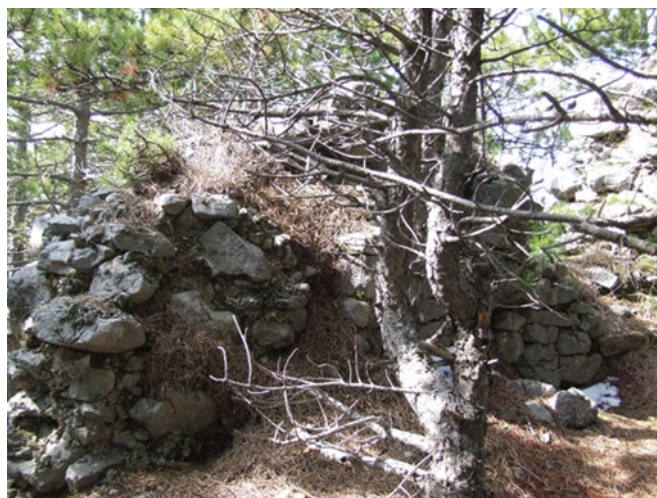
Sl. 336. Pogled na ostatke kružne kule u temelju na zapadu utvrde
