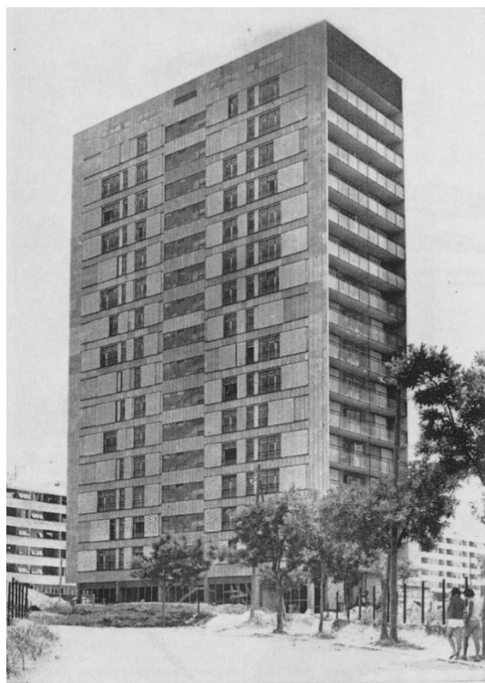
Sl. 2.7. Primjeri stambenih tornjeva pravokutne tlocrtne osnove sa stubištem uz fasadu Drago Ibler, Stambeno-poslovni toranj u Martićevoj ulici, Zagreb, 1956.-1958. (a, b) Ivo Radić, Stambeni tornjevi u Spinutu, Split, 1964.-1969. (c, d)
