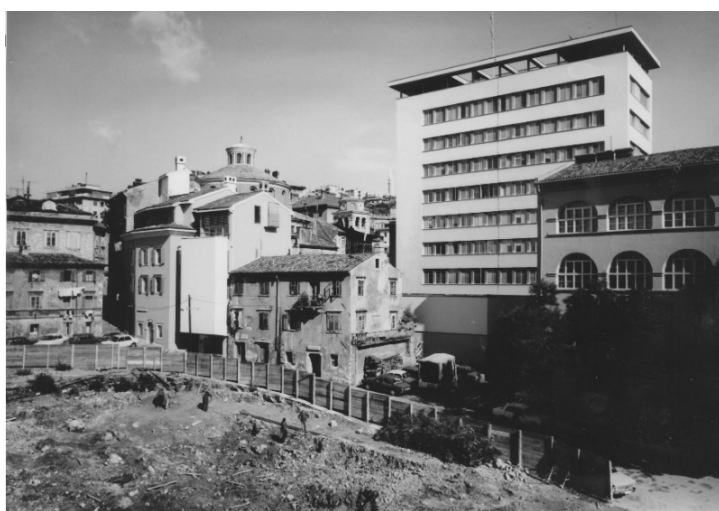
Sl. 5.43. Nikola Franković i David Bunetta (Rijeka-projekt), Upravna zgrada Sekretarijata unutrašnjih poslova NO Kotara Rijeka, Stari grad, Rijeka, 1961.
