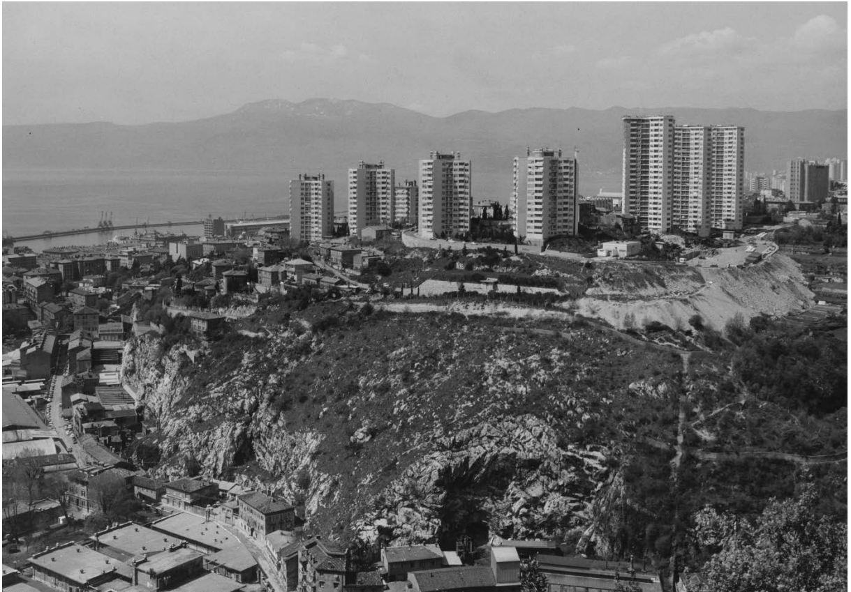
Sl. 6.34. Pogled na stambene tornjeve Kozale prije izgradnje nadvožnjaka gradske obilaznice preko kanjona Rječine, snimljeno oko 1978.
