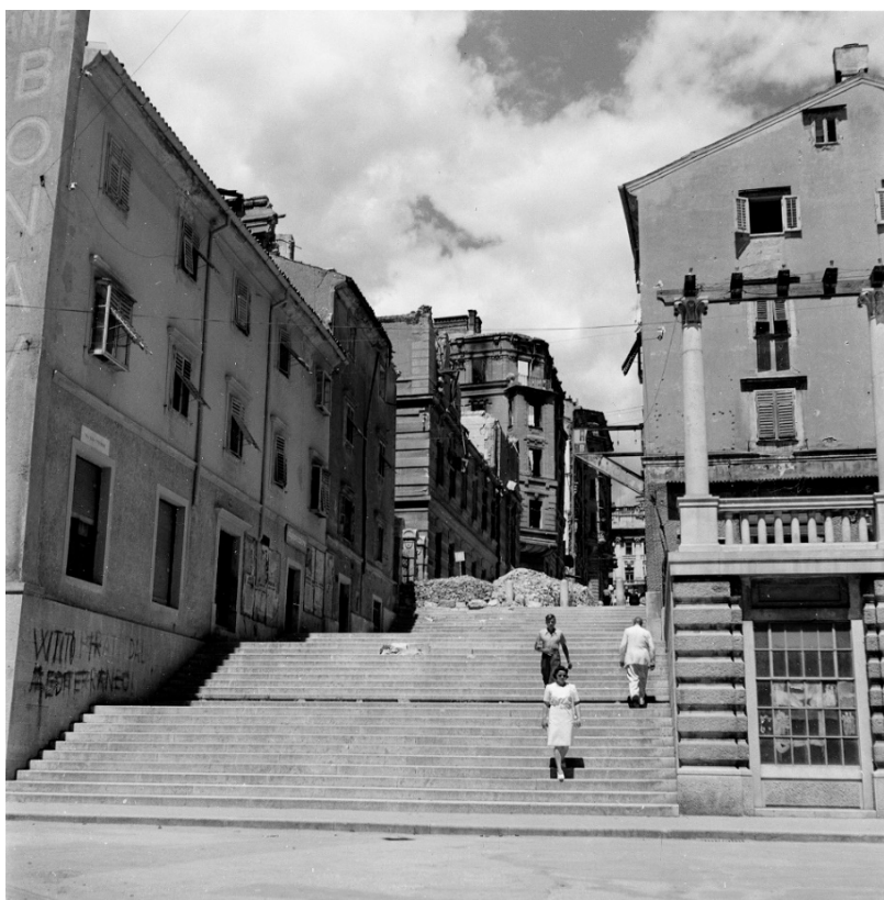
Sl. 4.2. Ruševine zgrada Prencis i Penso u Supilovoj ulici, Rijeka, snimljeno 1945.
