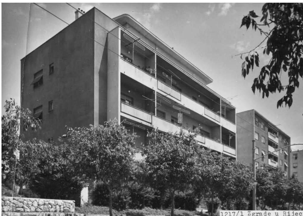
Sl. 4.50. Egon Holländer, Višestambena zgrada u Ulici Janka Polića Kamova 81, Rijeka, 1957.
