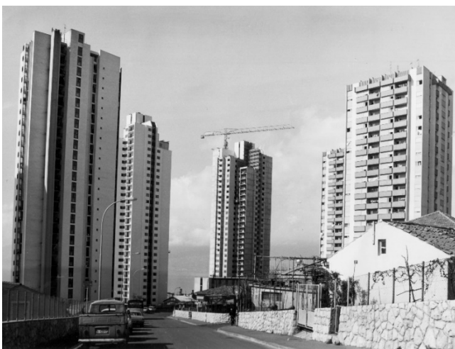
Sl. 6.48. Pogled na stambene tornjeve u središtu Podmurvica, snimljeno oko 1978. godine
