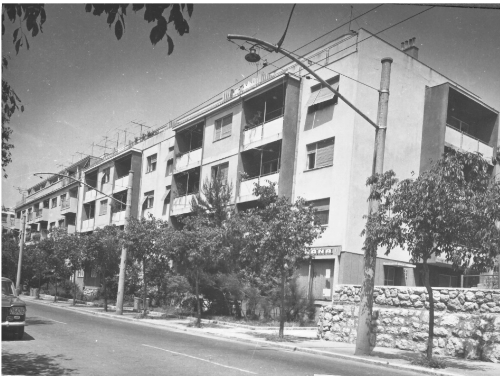
Sl. 4.49. Egon Holländer, Višestambene zgrade u Ulici J. Polića Kamova 77-79, Rijeka, 1957.
