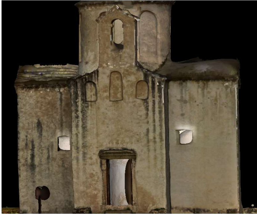
Slika 50. Greške vidljive na krovu novog 3D modela crkve sv. Križa
